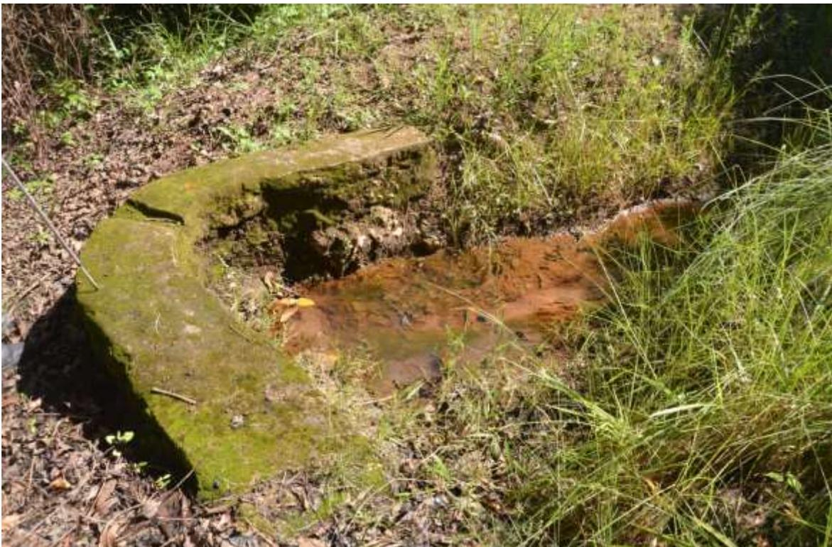
Foto 55: Barraginha de retenção da água das nascentes do córrego Rasgado para captação por gravidade.
