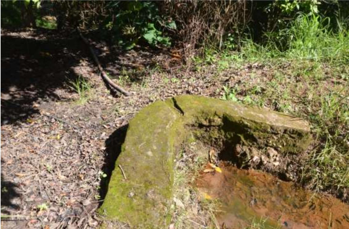
Foto 56: Barraginha de retenção da água das nascentes do córrego Rasgado para captação por gravidade, mostrando a tubulação em direção à caixa d'água.
