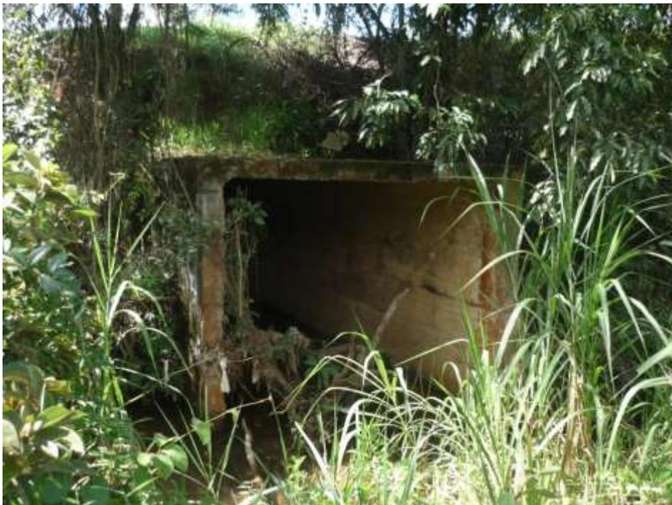
Foto 149. Galeria de concreto para passagem do córrego Rasgado sob a EPDB.
