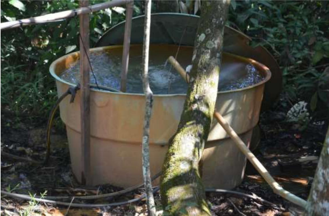
Foto 60: Detalhe da caixa d'água de abastecimento da ocupação irregular, mostrando a vazão captada do córrego Rasgado (Tubo de 75 mm).
