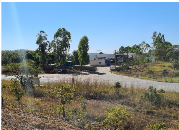
Figura 117. Fonte emissora em área rural: unidade industrial às margens da DF-205.
