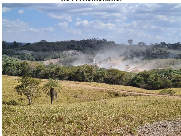
Figura 121. Fonte emissora em área rural associada a atividade industrial: pedreira Contagem vista a partir de propriedade rural lindeira.
