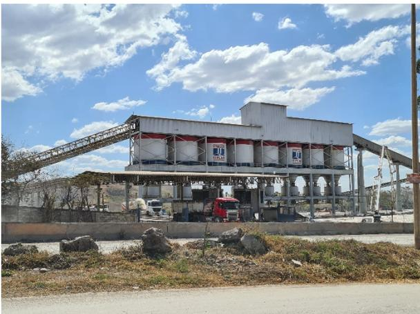
**Figura 95. Silos de cimento e estruturas de ensacamento na Ciplan.**
