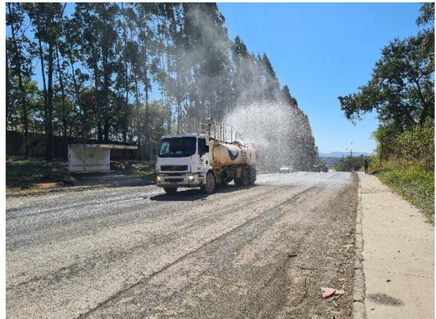
Figura 98. Caminhão pipa da CIPLAN com aspersor de água na DF-205. A aspersão de água promove o abatimento das partículas suspensas no ar.
