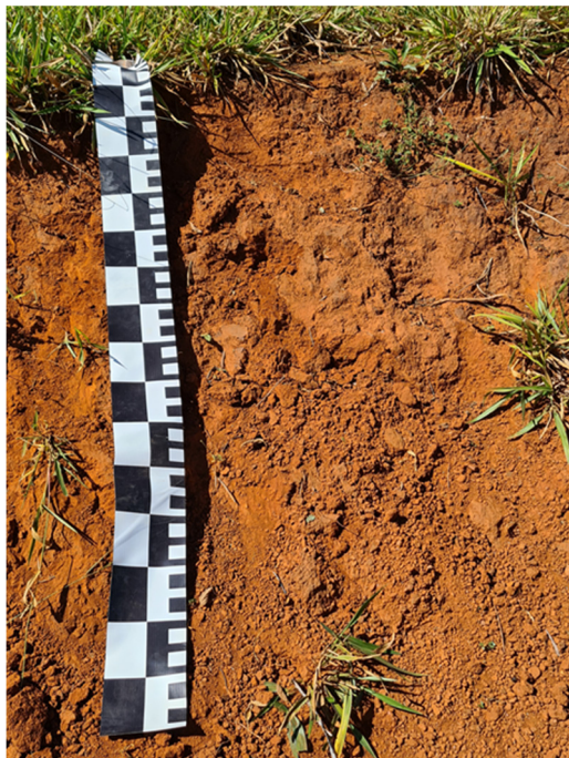
Figura 53. Perfil de Nitossolo vermelho em talude de corte.
