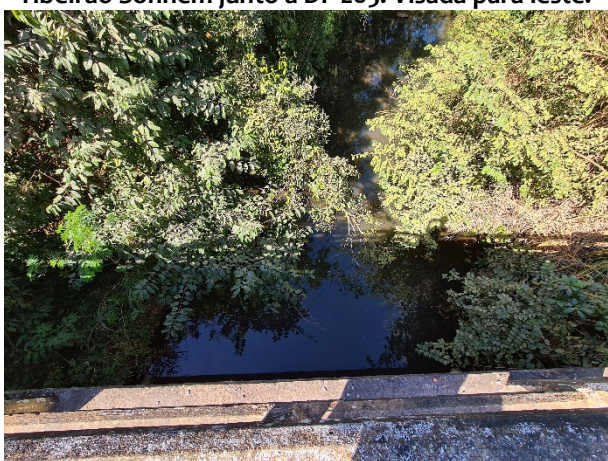
Figura 65. Vista à montante do ribeirão Sonhém sob a ponte da DF-205.
