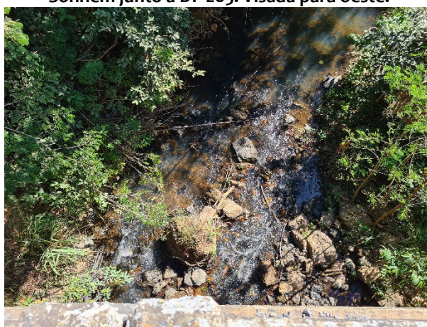
Figura 66. Vista à jusante do ribeirão Sonhém sob a ponte da DF-205.
