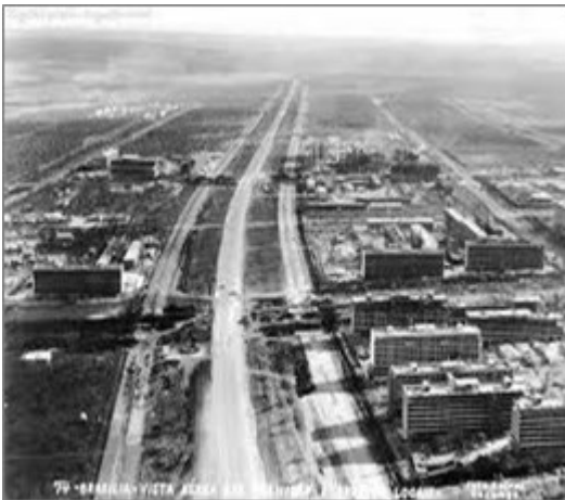
Imagens da construção de Brasília Fonte: CHISTOFORM. Blog (2012).
