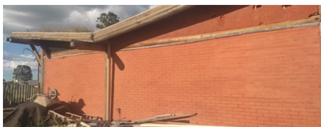
Figuras de 1 a 4: Sistema de captação e armazenamento de águas pluviais
