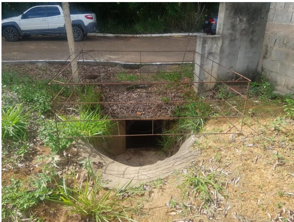
Figura 5 - Bueiro existente na frente do lote de forma a captar toda a água pluvial proveniente do canal à montante, bem como a gerada no lote
