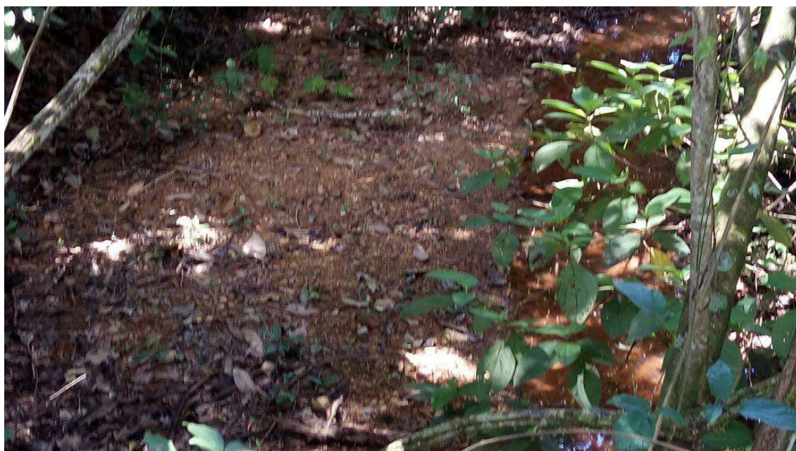
Foto 07 - Aspecto do leito receptor das águas pluviais, após o encontro com a confluência do braço da nascente do córrego Barro Branco.
