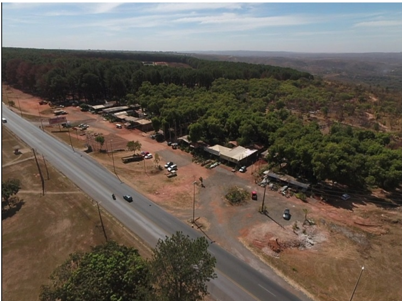
Figura 04: Vista aérea do Polo de Floriculturas. Ao fundo, a Estação de Tratamento da CAESB e a floresta dos pinheiros.
