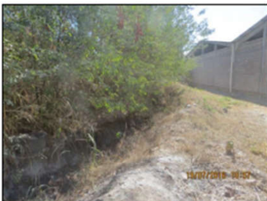
Foto 75: Vala de drenagem pluvial localizada no trecho sudeste da base do talude da pilha de estéril.
