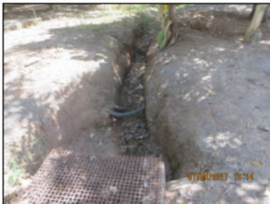
Foto 81: Vala interligada ao poço de visita da rede de drenagem pluvial da área administrativa.
