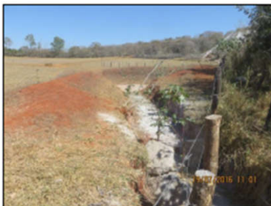
Foto 76: Vala de drenagem pluvial localizada no trecho sul da base do talude da pilha de estéril.
