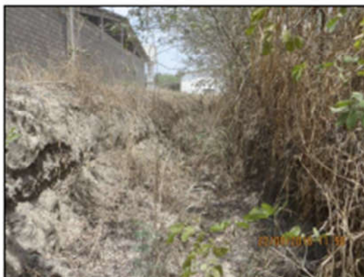
Foto 74: Aspecto interno da vala localizada no trecho leste da base do talude da pilha de estéril.
