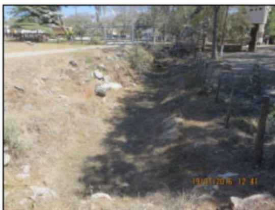
Foto 83: Vala que recebe os efluentes pluviais oriundos da área administrativa e escoam em direção ao corpo receptor.
