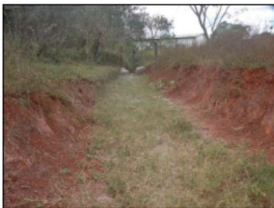
Foto 79: Aspecto interno da vala localizada no trecho sul da base do talude da pilha de estéril.
