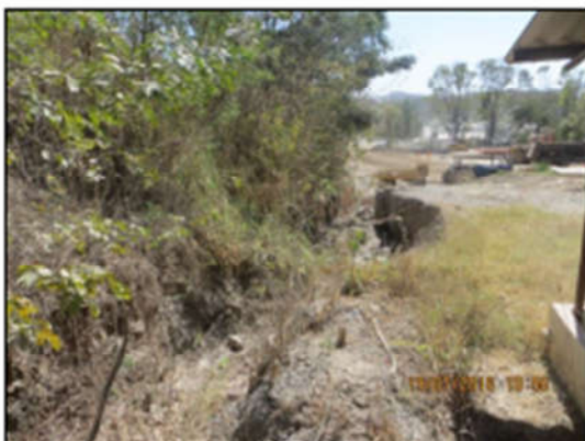
Foto 73: Vala de drenagem pluvial localizada no trecho leste da base do talude da pilha de estéril.
