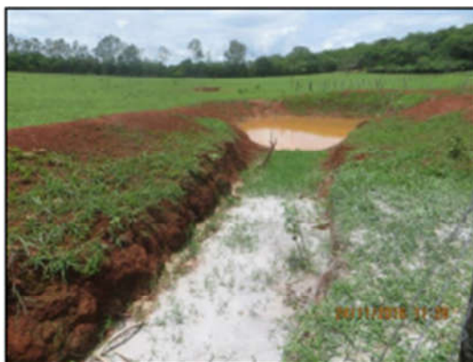
Foto 78: Trecho final da vala de drenagem pluvial e a bacia de detenção onde reserva a água escoada.
