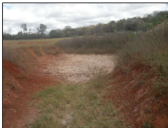
Foto 80: Trecho final da vala de drenagem pluvial e a bacia de detenção onde reserva a água escoada.
