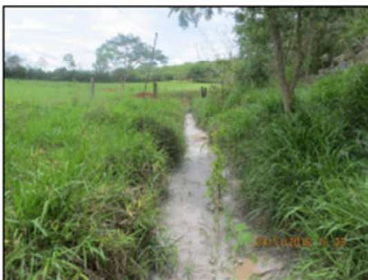
Foto 77: Aspecto interno da vala localizada no trecho sul da base do talude da pilha de estéril.
