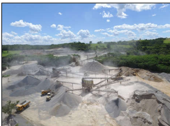
Figura 252: Vista aérea de área de beneficiamento.
