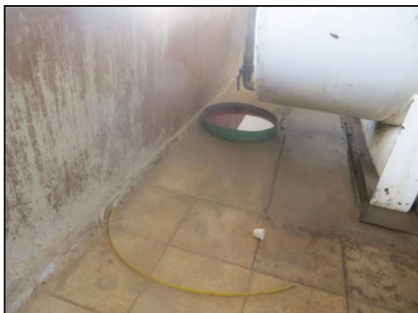
Figura 239: Coordenadas UTM ( Datum Sirgas 2000, fuso 23 L): 200.712 m E; 8.282.576 m S. Canaletas
