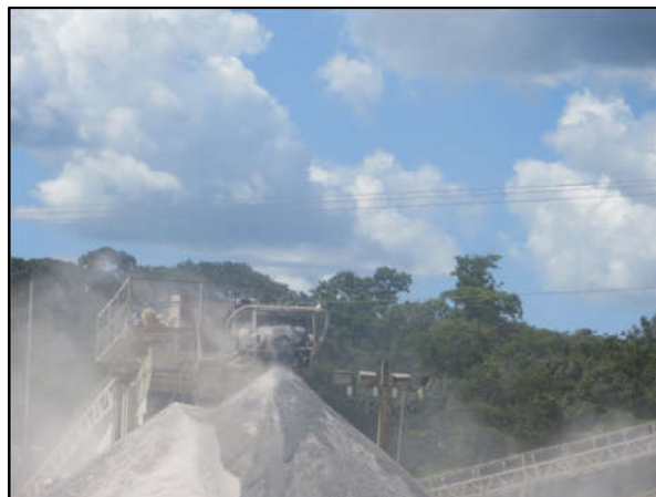
Figura 235: Coordenadas UTM ( Datum Sirgas 2000 , fuso 23 L): 200.717 m E; 8.282.700 m S. Vista de Área de beneficiamento.
