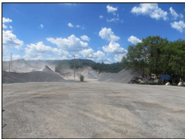
Figura 236: Coordenadas UTM ( Datum Sirgas 2000 , fuso 23 L): 200.749 m E; 8.282.677 m S. Pátio de operação.
