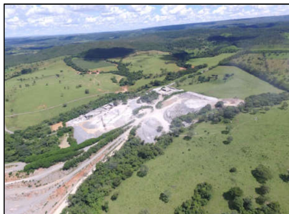
Figura 251: Vista aérea da área administrativa da PEDREIRAS CONTAGEM, 2016.
