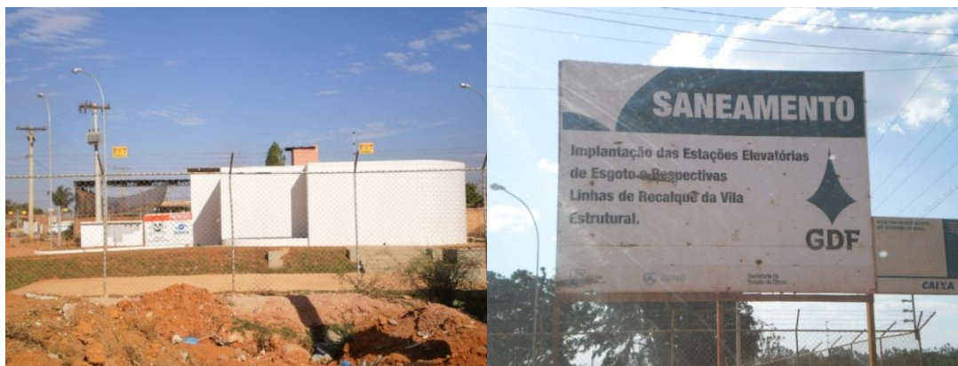
Figura 193 – Implantação do sistema de esgotamento sanitário na Vila Estrutural.
