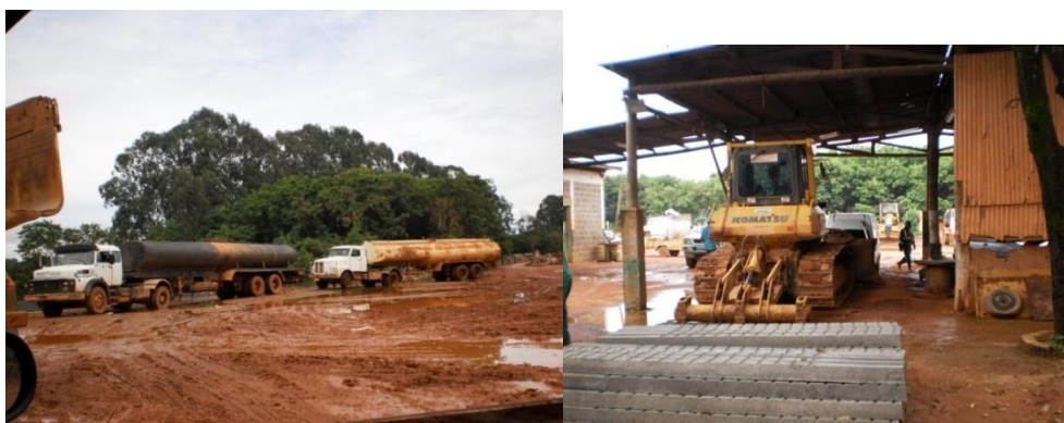
Figura 209 – Maquinários utilizados no aterro.
