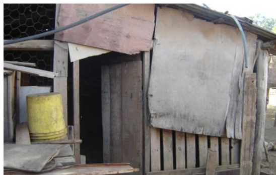
Figura 134 - Detalhe de galpão de madeira.
