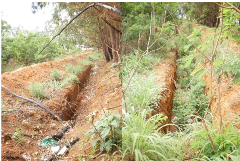
Figura 197 – Valas existentes dentro da área do Aterro do Jóquei para contenção de águas pluviais e de chorume.
