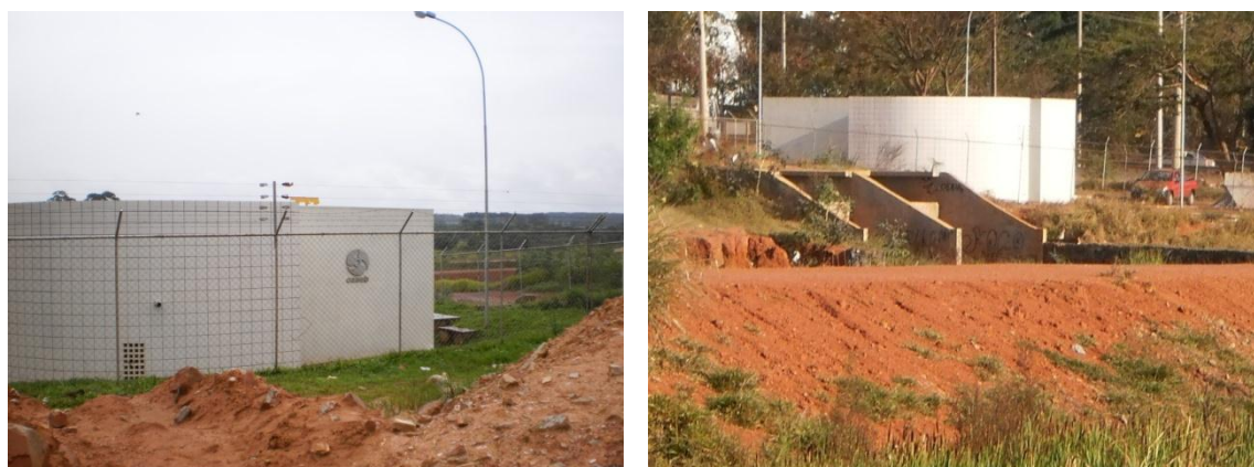
Figura 194 – Estação elevatória da Caesb.
