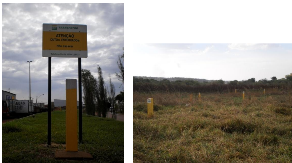
Figura 204 – Demarcações de Polidutos da Petrobrás às margens da rodovia DF-095 e inserido na ARIE Córrego Cabeceira do Valo.
