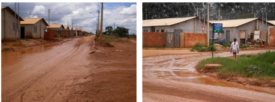
Figura 195 – Situação da pavimentação existente à leste da ARIE Córrego Cabeceira do Valo.
