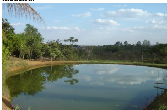
Figura 136 - Detalhe de tanque escavado.
