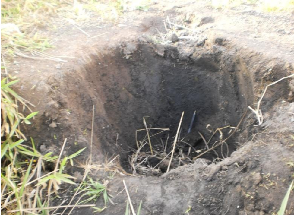
Figura 23 - Aspecto escuro do solo em trincheira aberta nas proximidades do dissipador de energia localizado no extremo sul da ARIE do Córrego Cabeceira do Valo (coordenada UTM 178161;8252596).
