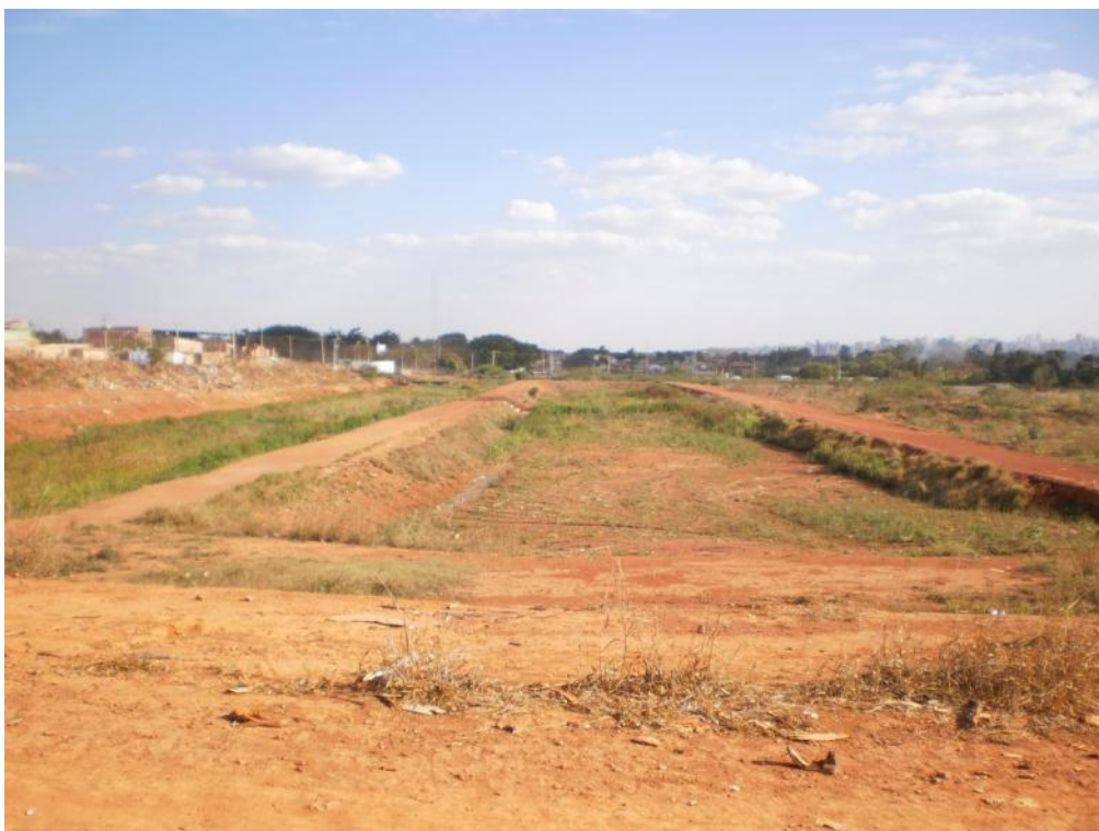
Figura 27 – Bacias de contenção de drenagem pluvial.
