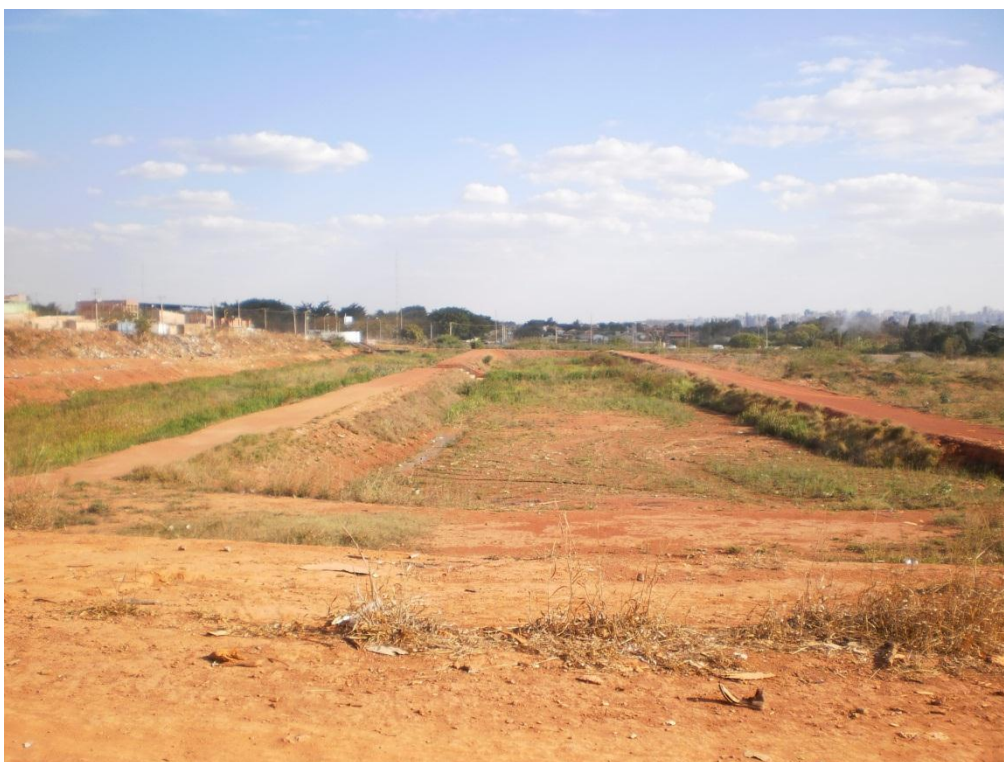
Figura 201 – Bacias de contenção de drenagem pluvial.
