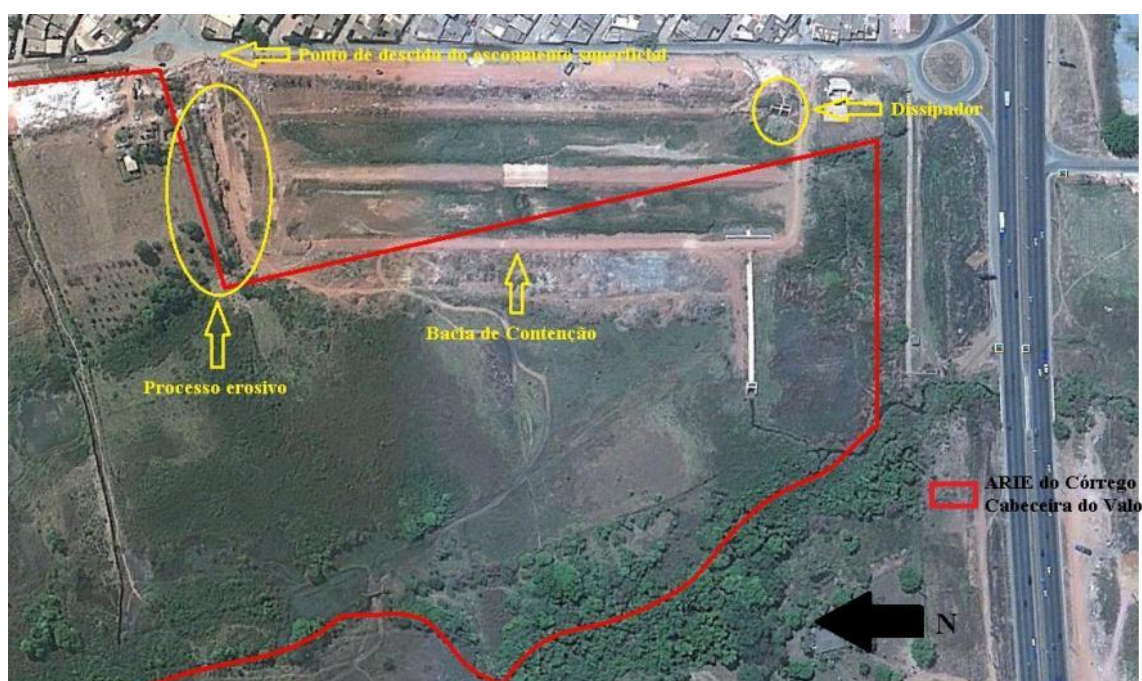
Figura 29 – Imagem de satélite ilustrando a Bacia de Contenção e o processo erosivo ocasionado pela falta de drenagem pluvial.
