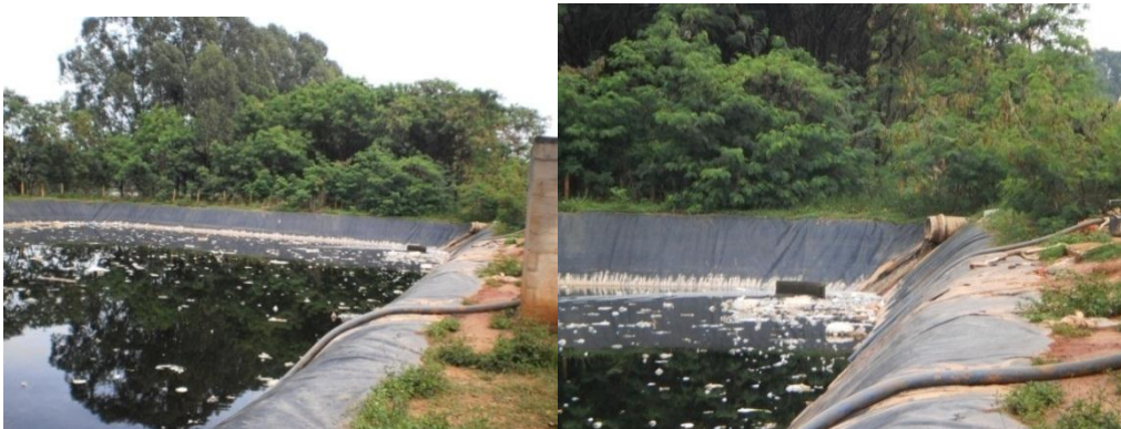
Figura 211 – Lagoa de chorume. Destaque para o duto de chorume.
