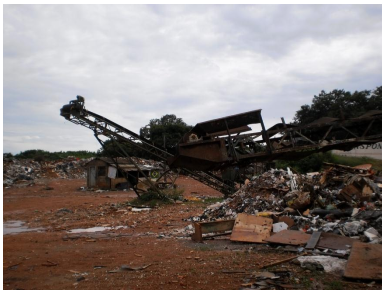
Figura 210 – Sucatas da esteira que constituía a Central de Processamento de Entulhos.
