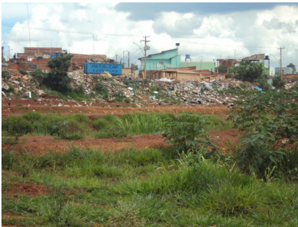
Figura 32– Depósito de entulho no talude da bacia de contenção.
