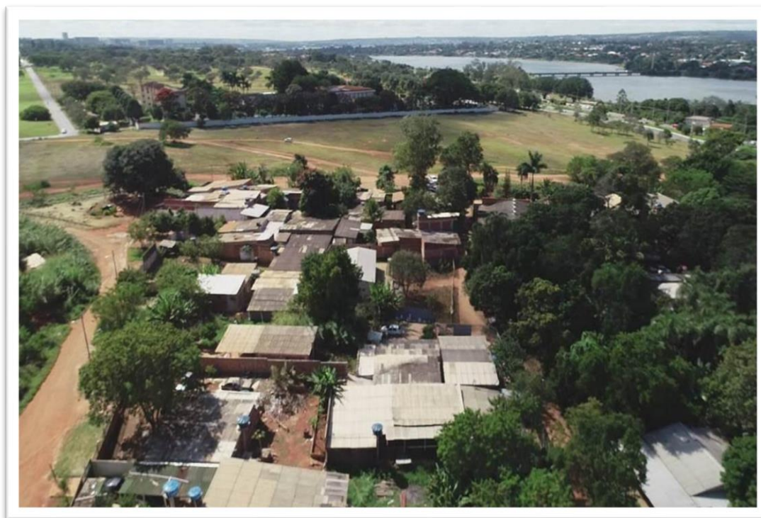
Figura 35: Fotografia de Drone das ocupações (10/05/ 2018).
