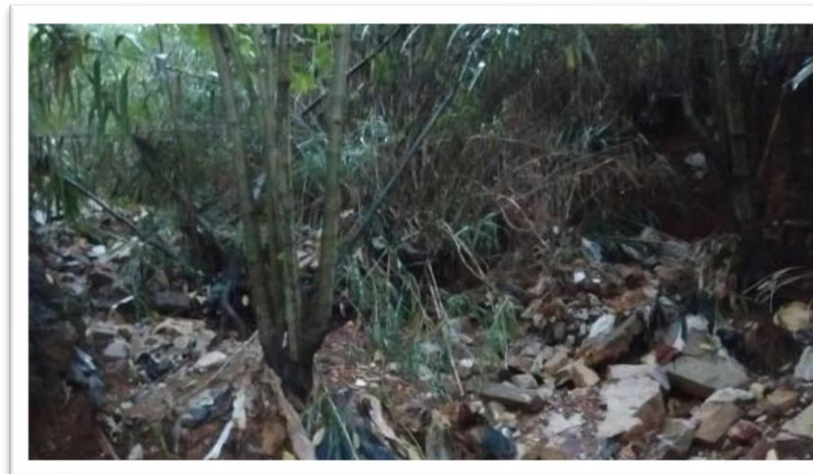
Figura 42: Carreamento de grandes quantidades de lixo e material de aterro para dentro da unidade.
