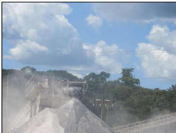
Figura 188: Coordenadas UTM ( Datum Sirgas 2000 , fuso 23 L): 200.717 m E; 8.282.700 m S. Vista de Área de beneficiamento.
