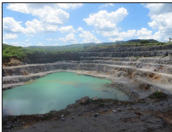
Figura 170: Coordenadas UTM ( Datum Sirgas 2000, fuso 23 L): 200.780 m E; 8.283.082 m S. Vista da cava em operação.
