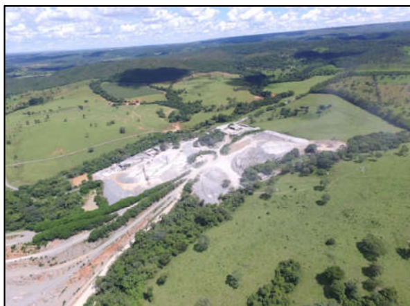
Figura 204: Vista aérea da área administrativa da PEDREIRAS CONTAGEM, 2016.
