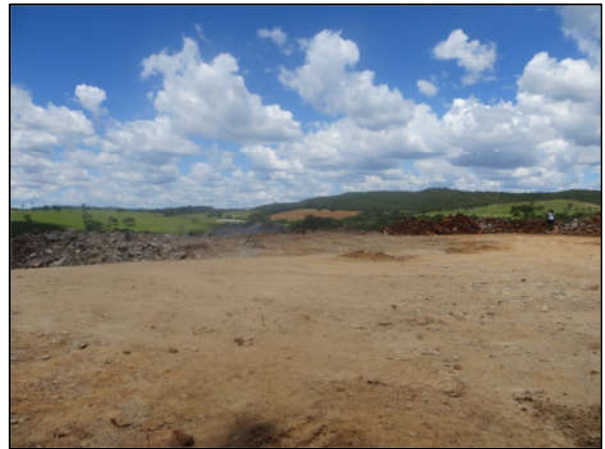
Figura 178: Coordenadas UTM ( Datum Sirgas 2000 , fuso 23 L): 200.419 m E; 8.283.329 m S. depósito de estéril e top soil.
