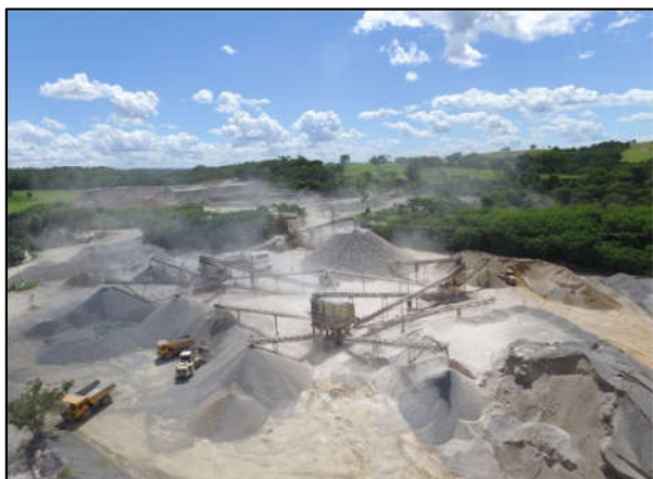
Figura 205: Vista aérea de área de beneficiamento.
