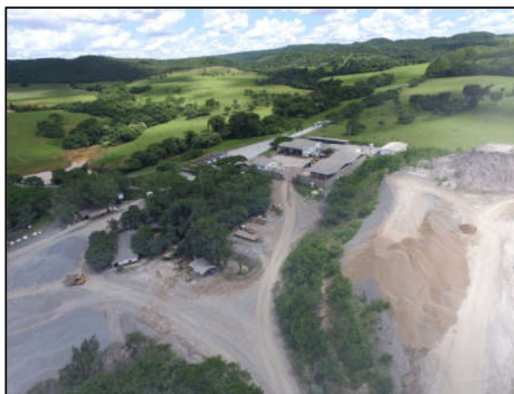
Figura 206: Vista aérea da área administrativa da PEDREIRAS CONTAGEM.
