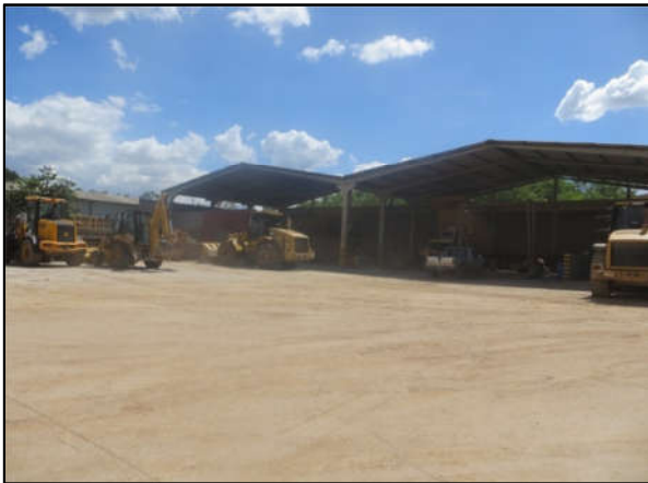
Figura 197: Coordenadas UTM ( Datum Sirgas 2000, fuso 23 L): 200.701 m E; 8.282.584 m S. Vista do pátio da oficina.
