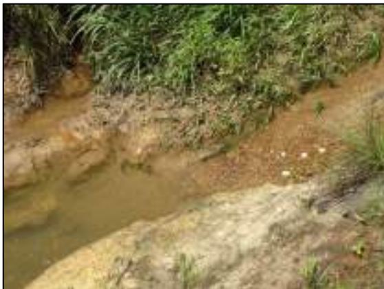
Figura 81 – (CVC01) Assoreamento. Coordenada UTM - SIRGAS 2000 / Zona 23S/E- 176998,3/S-8245734,83. Data da foto: 10/10/2016 às 10 h e 46 min
