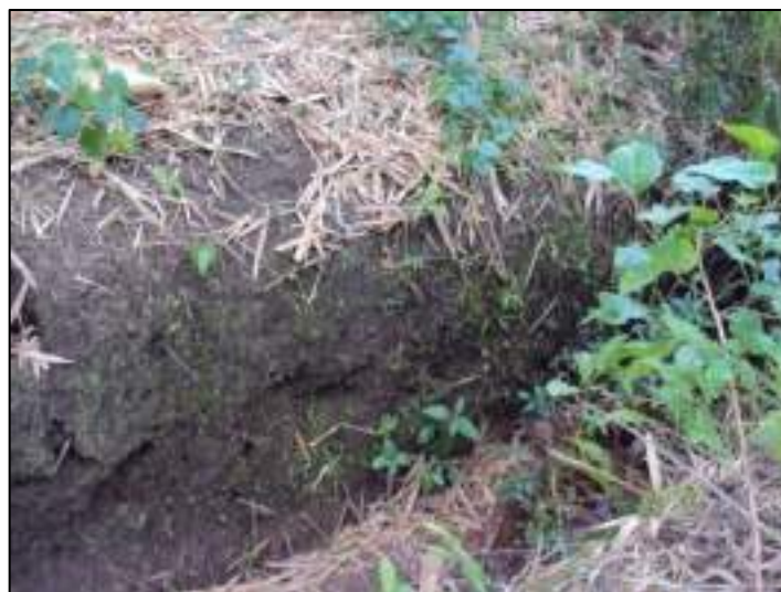
Figura 385- Canais de drenagem construídos por moradores em região de vereda para posterior ocupação.
