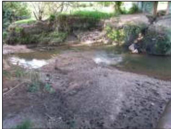
Figura 102 – (CVP02) Assoreamento e Erosão Coordenada UTM - SIRGAS 2000 / Zona 23S/E- 179331,13/S-8247250,97. Data da foto: 10/10/2016 às 16 h e 35 min
