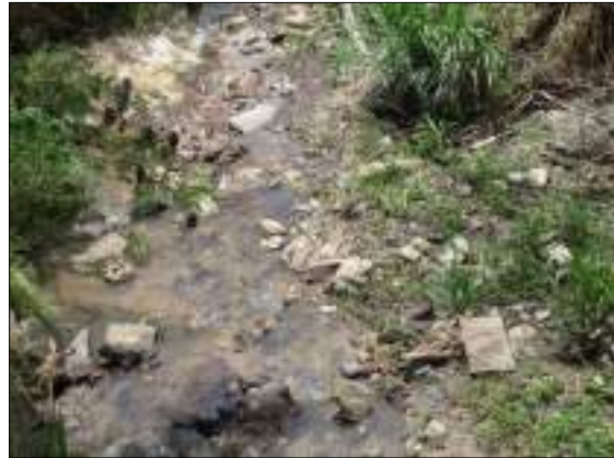
Figura 127 – Constatação de erosão e assoreamento nas margens do Córrego Vereda Grande – Imagem 02 (Ponto 991)
