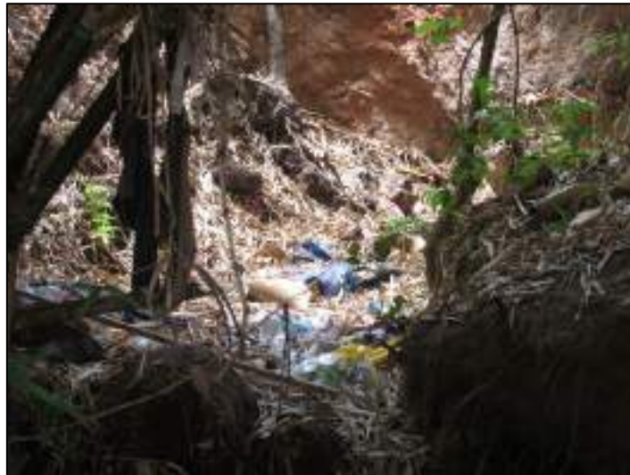
Figura 56 - (AD 06) Erosão e Resíduos Sólidos às Margens do Córrego Arniqueira Coordenada UTM - SIRGAS 2000 / Zona 23S/ E- 178704,2138 /S- 8245643,667. Data da foto: 10/10/2016 às 11 h e 27 min.
