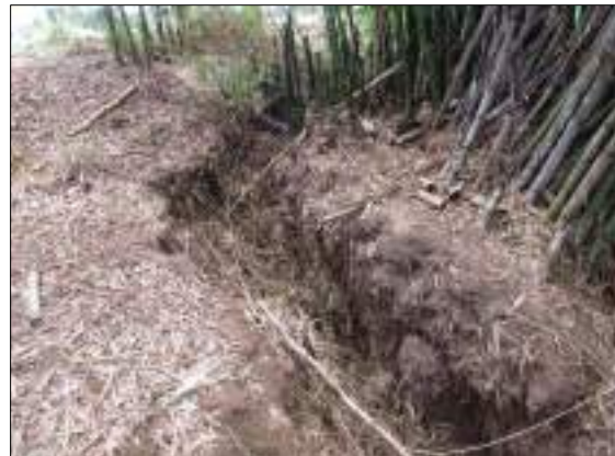
Figura 110 – Presença de erosão nas margens do Córrego Arniqueira (Ponto 983)
