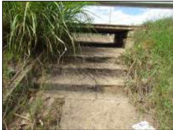
Figura 95 – (CVG02) Lançamento Direto da DF-079. Coordenada UTM - SIRGAS 2000 / Zona 23S/E- 180133,69/S-8244166,99. Data da foto: 10/10/2016 às 14 h e 27min
