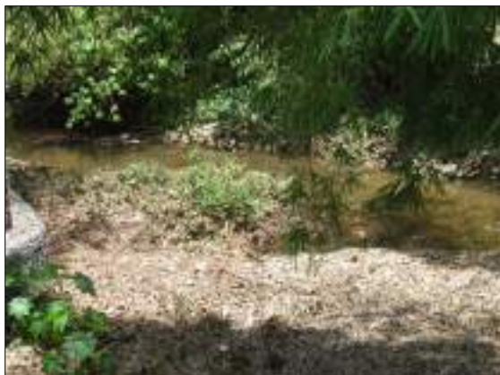
Figura 114 – Constatação de assoreamento do Córrego Arniqueira (Ponto 987)
