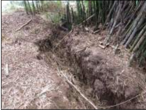
Figura 54 - (AD06) Erosão às Margens do Córrego Arniqueira Coordenada UTM - SIRGAS 2000 / Zona 23S/E- 178704,2138 /S- 8245643,667. Data da foto: 10/10/2016 às 11h 23 min.
