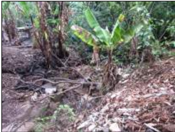
Figura 90 – (CA03) Degradação das Margens Coordenada UTM - SIRGAS 2000 / Zona 23S/E- 177295,76/S-8244070,41. Data da foto: 10/10/2016 às 12 h e 12 min
