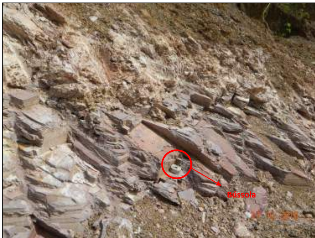
Figura 18: Afloramento nº 4, com ardósias da Formação Ribeirão do Torto, em corte de estrada. Fonte: Topocart, 2016.
