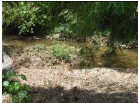
Figura 89 – (CA02) Assoreamento Coordenada UTM - SIRGAS 2000 / Zona 23S/E- 177401,6/S-8244441,89. Data da foto: 10/10/2016 às 12 h e 01 min
