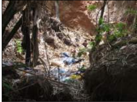
Figura 87 – (CA01) Resíduos Sólidos e Erosão Coordenada UTM - SIRGAS 2000 / Zona 23S/E- 178704,21/S-8245643,67. Data da foto: 10/10/2016 às 11 h e 26 min
