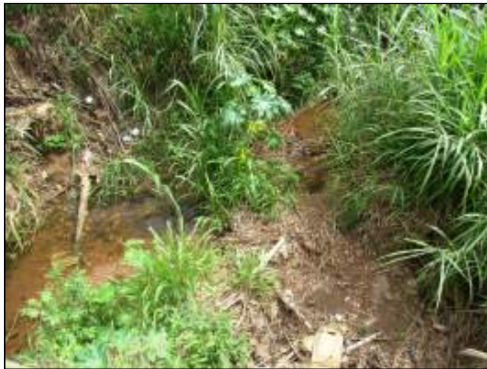
Figura 96 – (CVG02) Assoreamento Coordenada UTM - SIRGAS 2000 / Zona 23S/E- 180133,69/S-8244166,99. Data da foto: 10/10/2016 às 14 h e 28min
