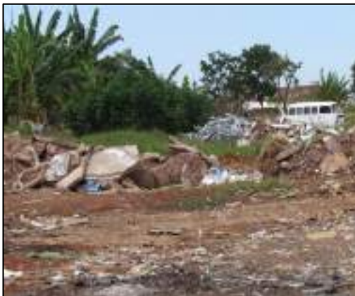
Figura 46 - (AD03) Resíduos de Construção Civil
