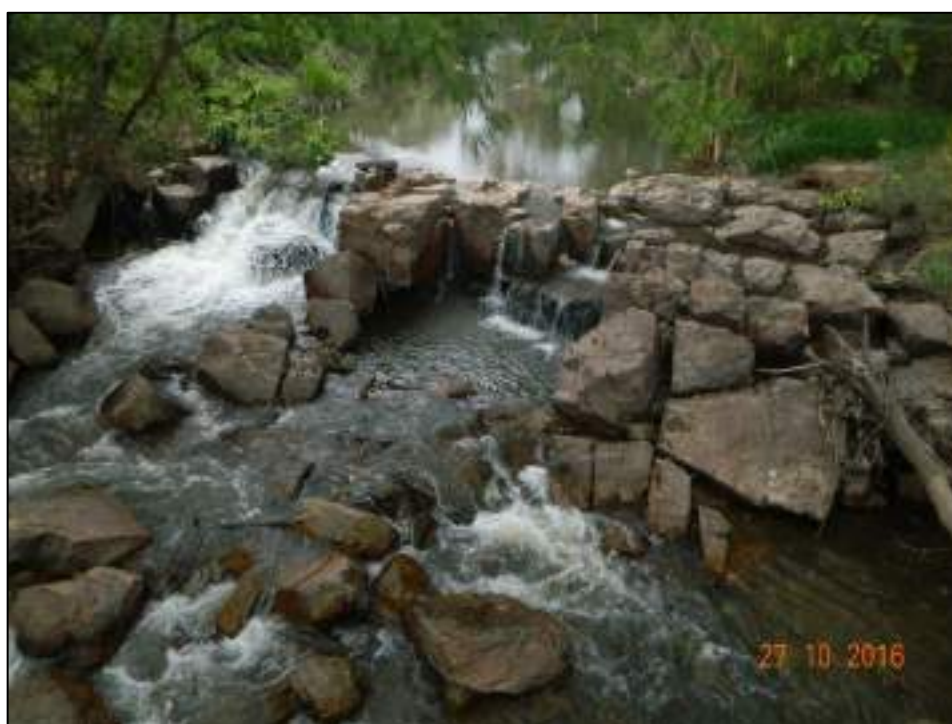
Figura 16: Afloramento nº 2, no córrego Vicente Pires, que mostra camada de quartzito maciço intensamente fraturada.
