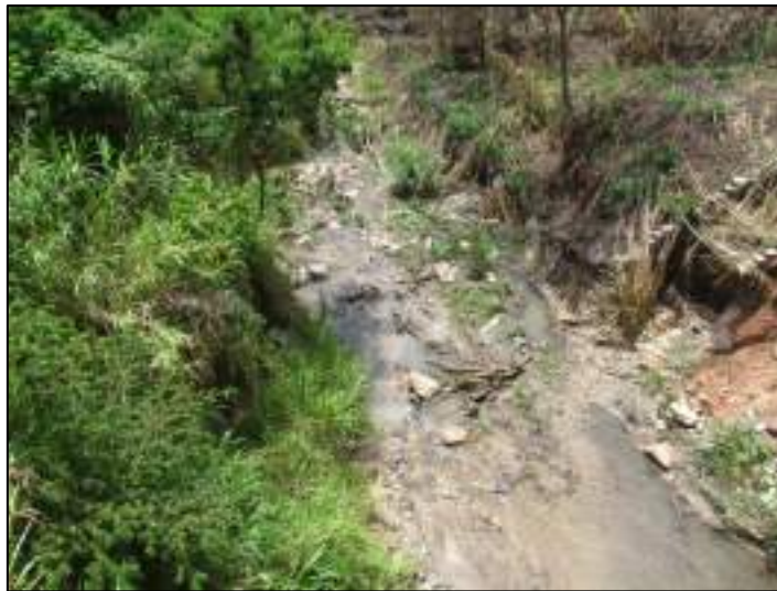
Figura 85 – (CVC02) Assoreamento Coordenada UTM - SIRGAS 2000 / Zona 23S/E- 178378,22/S-8246380,8. Data da foto: 10/10/2016 às 11 h e 07 min
