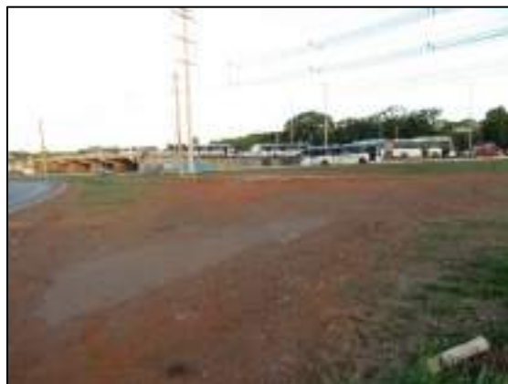
Figura 73 – (AD 15) Solo Exposto Coordenada UTM - SIRGAS 2000 / Zona 23S/E- 182434,2121 /S- 8243698,029. Data da foto: 10/10/2016 às 17 h e 48 min
