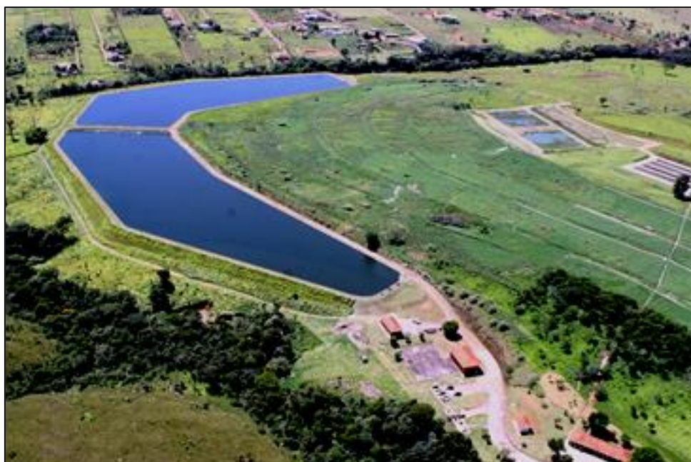
Foto 2.1: ETE São Sebastião
