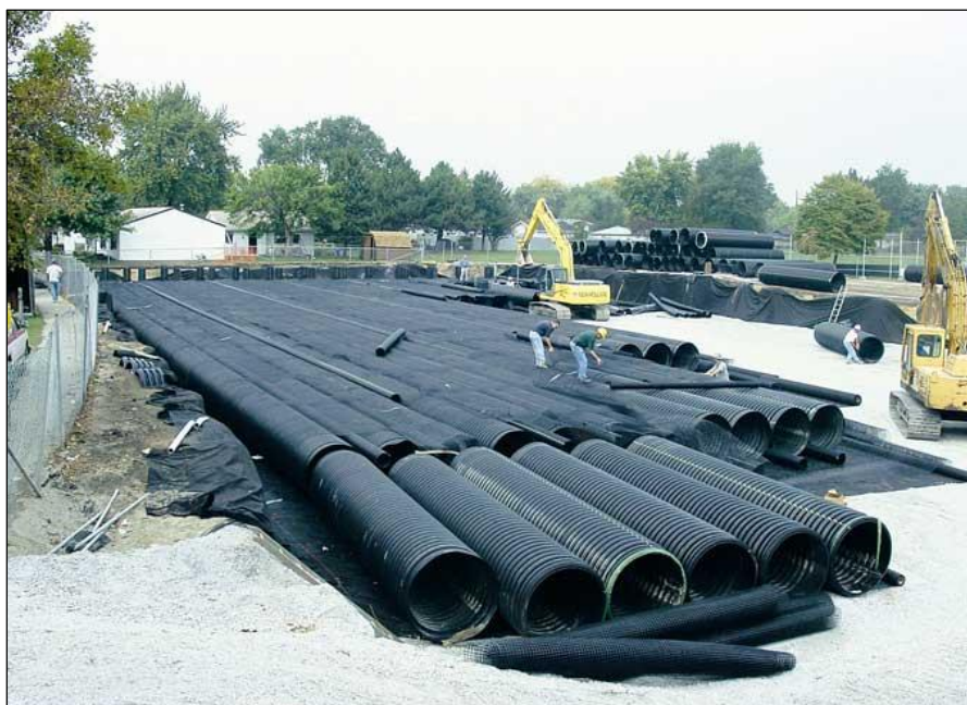
Figura 2.7: Esquema e exemplo de sistema enterrado de retenção.
