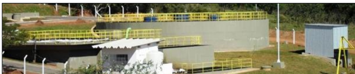
Foto 2.2: Visão Geral da ETE Compacta
