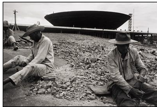
Foto 1.4: Operários (Candangos) trabalhando na construção de Brasília.
