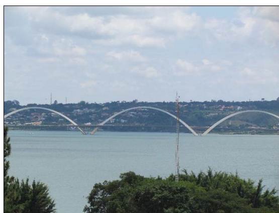
Foto 1.79: Ponte Juscelino Kubitschek. Data: 06/12/2016. UTM Zona 23 L 193025 m E 8247001 m N. Azimute: 124°.
