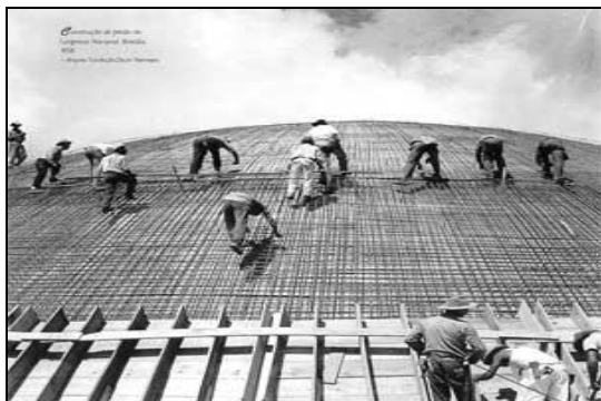
Foto 1.3: Operários (Candangos) trabalhando na construção de Brasília.
