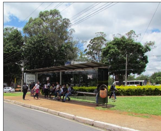
Foto 1.47: Parada de ônibus na DF-025. Data: 06/12/2016. UTM Zona 23 L 191880 m E 8245083m N. Azimute: 238°.
