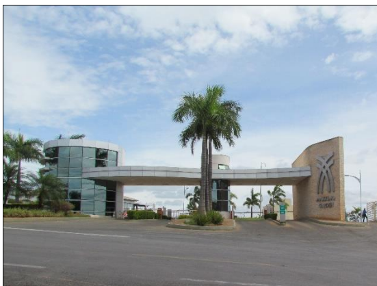
Foto 1.34: Condomínio localizado no Jardim Botânico. Data: 06/10/2016. UTM Zona 23 L 203638 m E 8243406 m N. Azimute: 283°.
