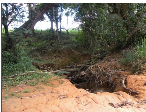
Foto 1.123: Exemplo de erosão em condomínio próximo à área do empreendimento.
