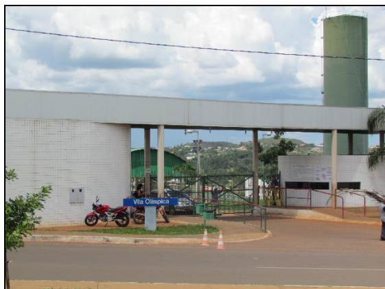
Foto 1.105: Vila Olímpica. Data: 06/12/2016. UTM Zona 23 L 202082 m E 8240955 m N. Azimute: 030°.
