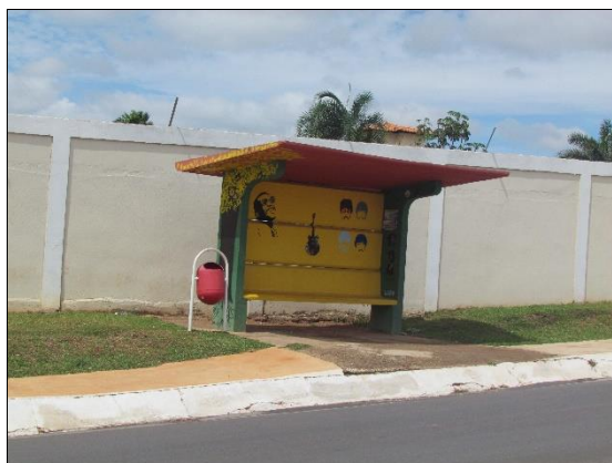
Foto 1.6: Parada de ônibus na estrada do sol. Data: 06/10/2016. UTM Zona 23 L 203650 m E 8243408m N. Azimute: 207°.
