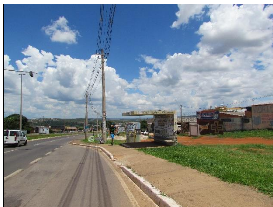
Foto 1.86: Parada de ônibus na DF-463. Data: 06/12/2016. UTM Zona 23 L 201694 m E 8240441m N. Azimute: 024°.
