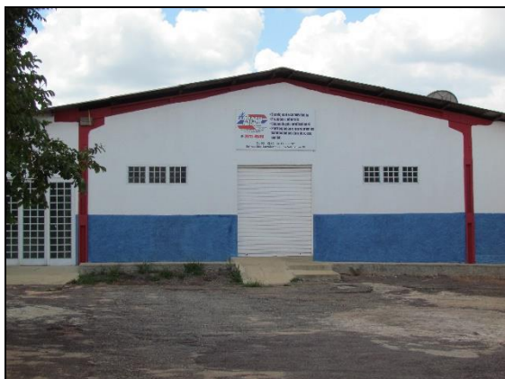
Foto 1.107: Associação Comunitária de São Sebastião - ASCOM. Data: 06/12/2016. UTM Zona 23 L 202611 m E 8240683 m N. Azimute: 285°.
