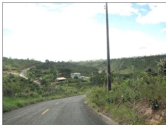
Foto 1.122: Pavimentação na área realizada por particulares.
