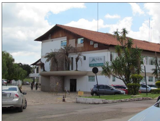
Foto 1.58: Hospital Brasília. Data: 06/12/2016. UTM Zona 23 L 191156 m E 8246014m N. Azimute: 049°.
