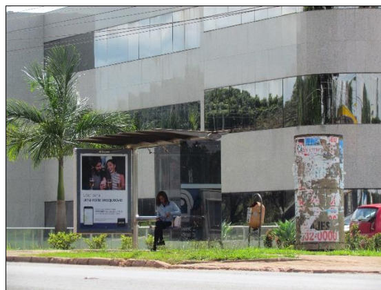
Foto 1.53: Parada de ônibus na DF-025. Data: 06/12/2016. UTM Zona 23 L 186378 m E 8244505 m N. Azimute: 130°.
