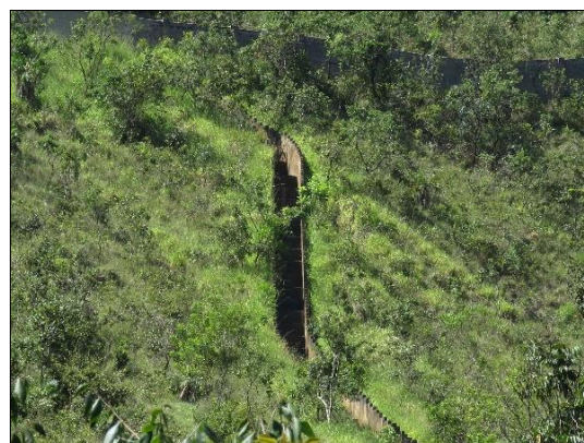
Foto 4.4: Canal de drenagem pluvial do condomínio Quintas do Sol.
