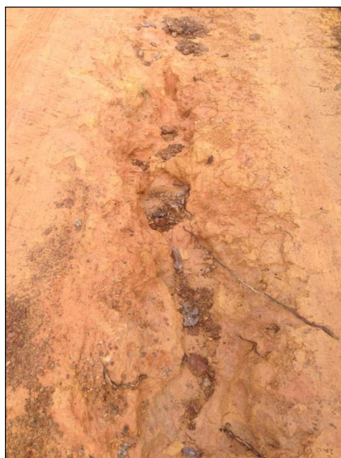
Foto 1.26: Sulco erosivo do tipo linear.
