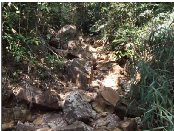
Foto 3.3: Presença de blocos na drenagem
