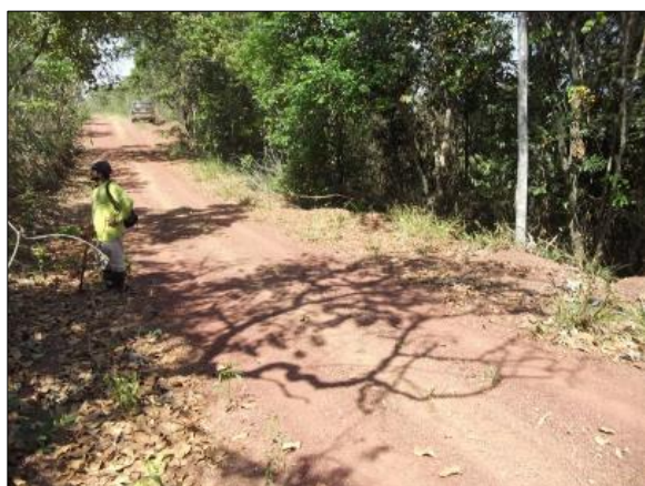
Foto 3.26: local onde começa a drenagem.
