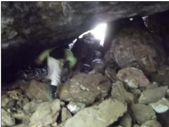
Foto 3.15: Parte interna do conduto principal. Ao fundo, saída para o ponto 07.
