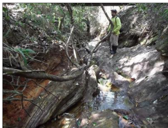
Foto 3.19: Drenagem no local.
