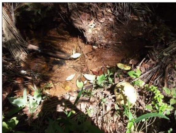
Foto 3.6: Calha da drenagem.
