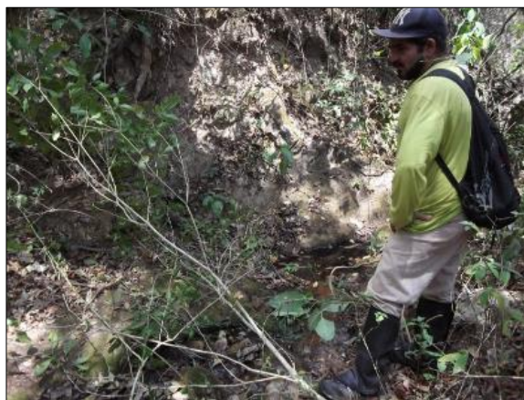
Foto 3.55: Ponto dentro da drenagem.
