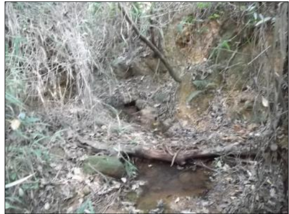
Foto 3.34: Detalhe do local da drenagem.
