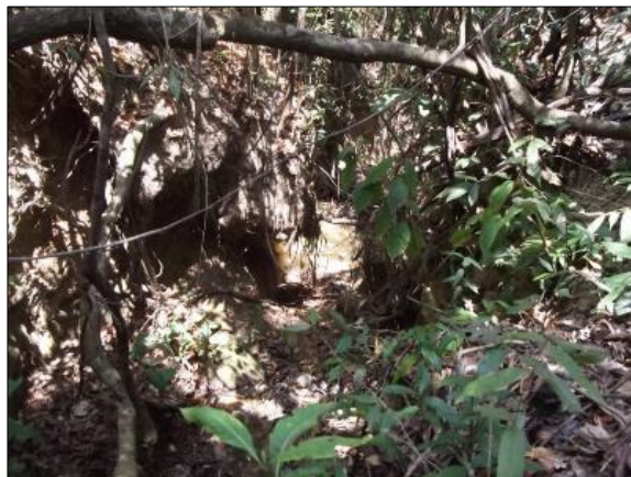
Foto 3.54: Local com solo de alteração e blocos de rocha no fundo da drenagem
