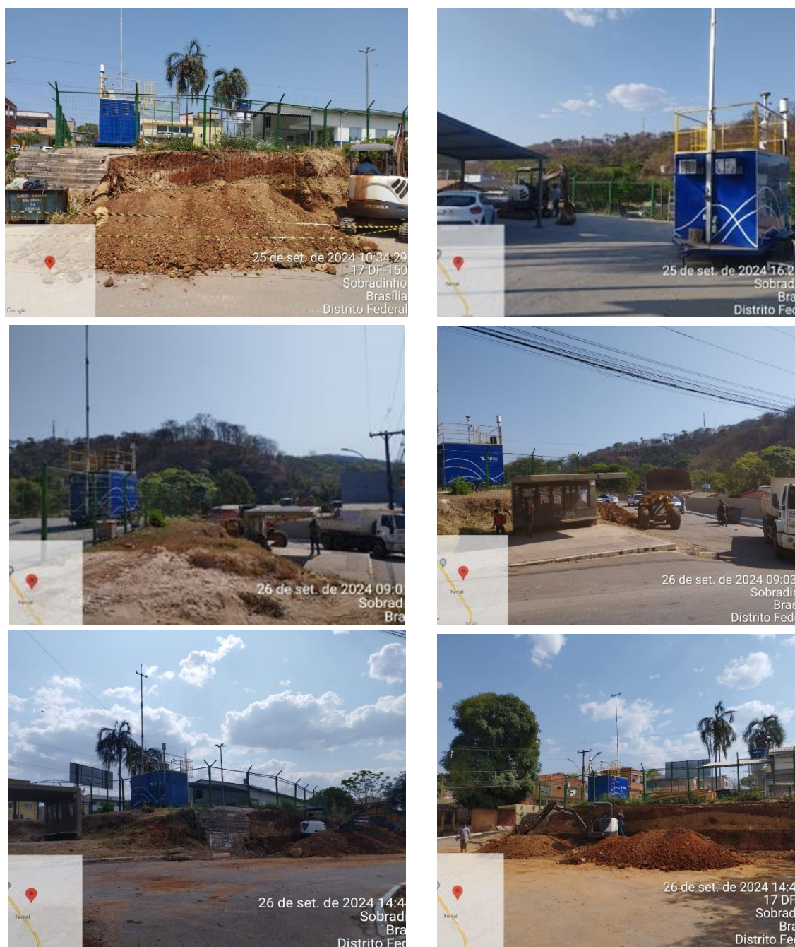
Figuras 7-7 a 7-12: Registro Fotográfico das atividades realizadas no CRAS.
