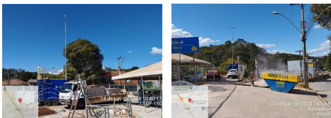
Figuras 7-1 a 7-2: Registro Fotográfico das atividades realizadas no CRAS.
