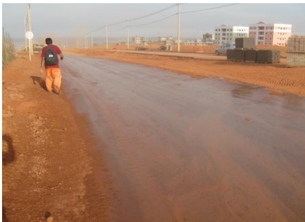
Figura 77 - Vias de circulação de caminhões umedecida.
