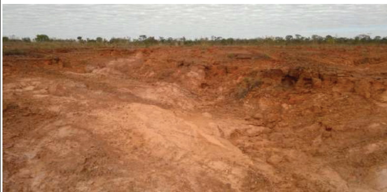
Erosão – Parque Córrego da Onça
