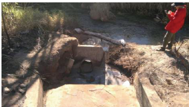
Derramamento de óleo em Planaltina Paranoá
