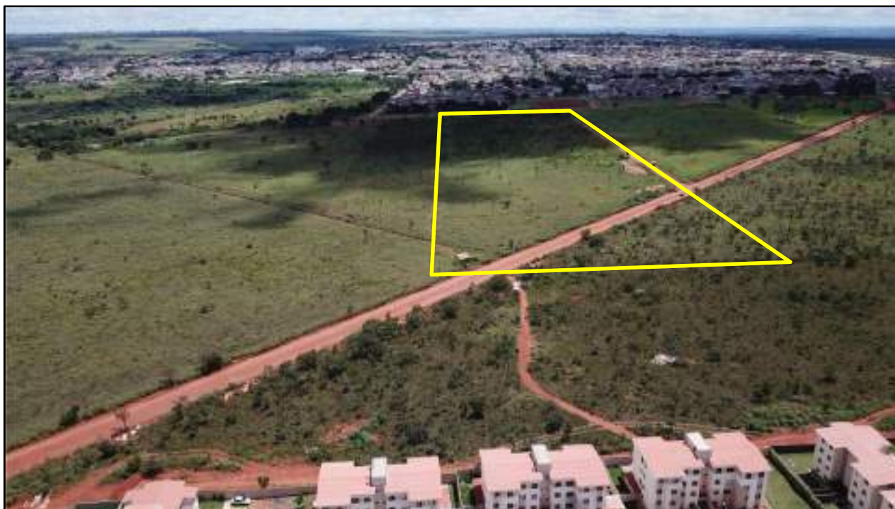
Foto 10: Poligonal do MEIRELES MRV na perspectiva sul da gleba, de onde se observa parte da malha urbana de Santa Maria (norte).
