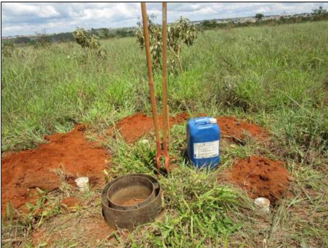
Foto 6: Tubos de PVC cravados no solo. Localização: 179.956 E / 8.226.085 N, zona 23 L.
