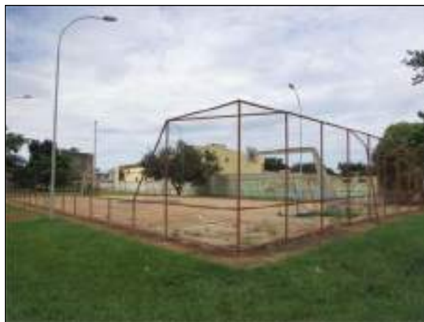
Foto 51: Equipamento Público Esportivo situado na EQ 418/518.
