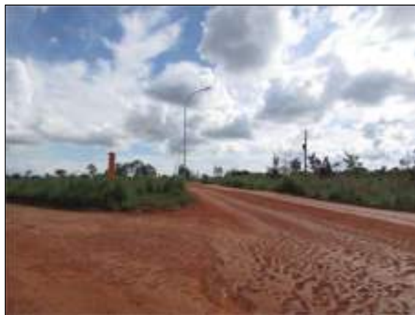
Foto 25: Trecho de interseção da rodovia VC-371 com a via de circulação que confronta com o limite leste da AID.
