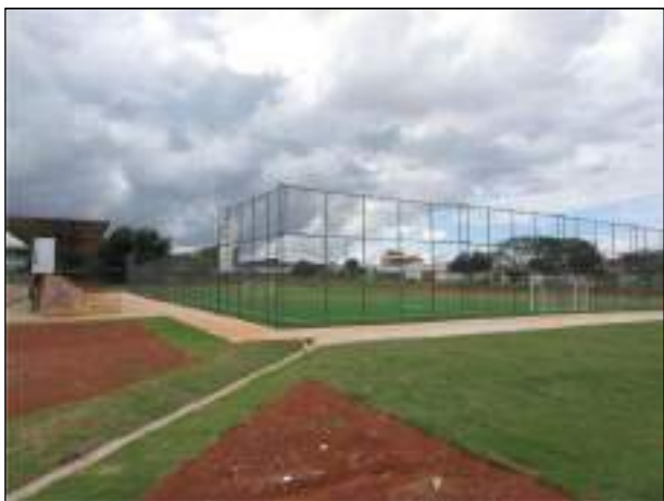
Foto 50: Equipamento Público Esportivo situado na EQ 418/518.
