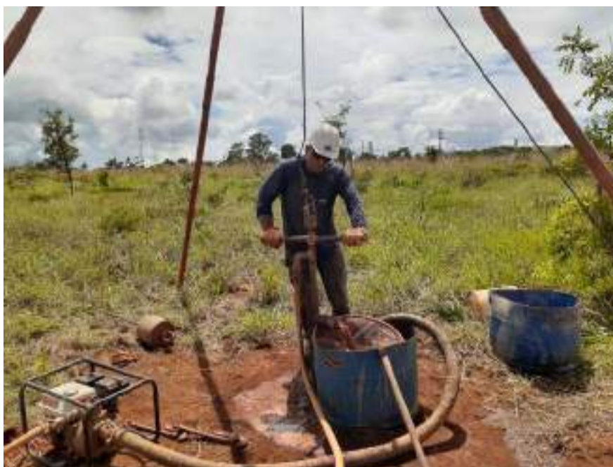
Figura 03. Foto da Execução no Local.
