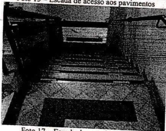
Foto 17 - Escada de acesso ao subsolo
