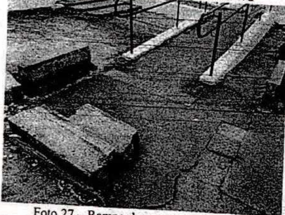
Foto 27 - Rampa de acesso pela via W2
