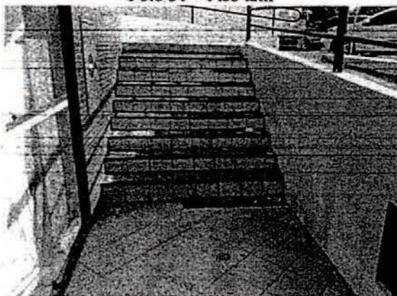
Foto 33 – escada de acesso
