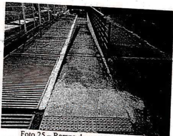
Foto 25 - Rampa de acesso pela via W2
