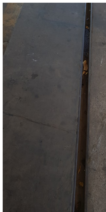
Foto 16 - Detalhe dos canaletes da área de abastecimento
