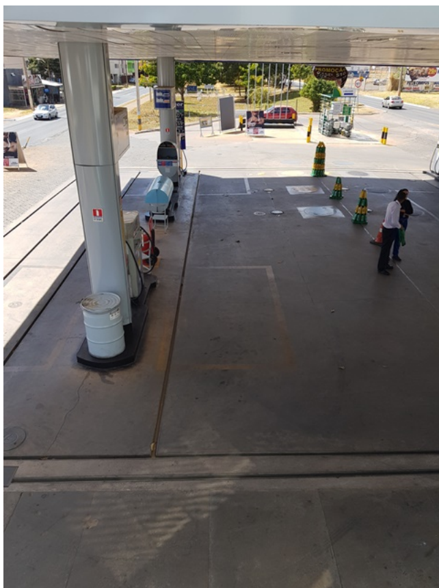
Foto 13 - Área de abastecimento do posto, em concreto liso e impermeabilizado
