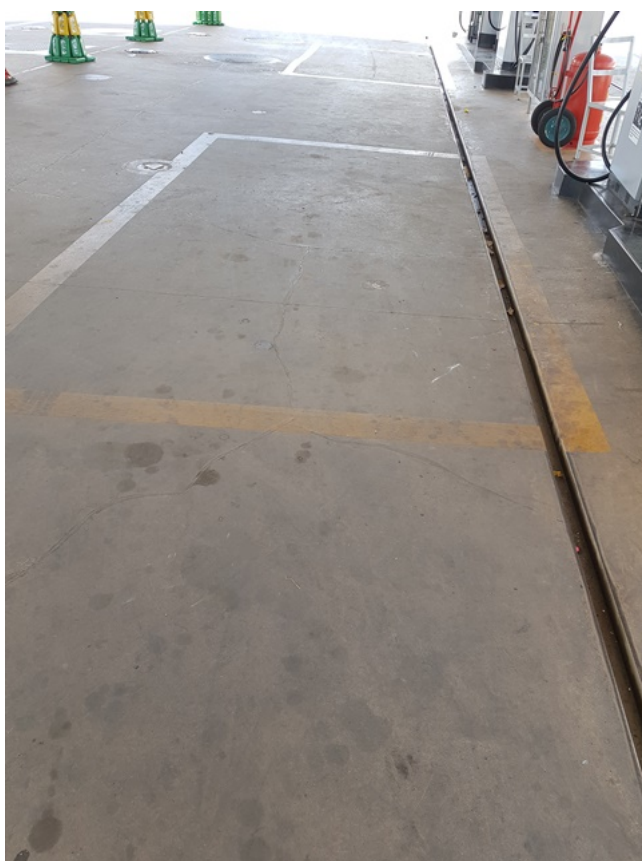
Foto 15 - Canaletas da área de abastecimento, em bom estado de manutenção e conservação
