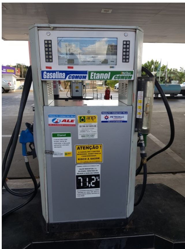
Foto 19 - Nova unidade de abastecimento já instalada no posto
