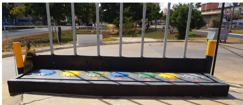
Foto 09 - Descarga selada a distância, circundada por canaletos e em bom estado de manutenção
