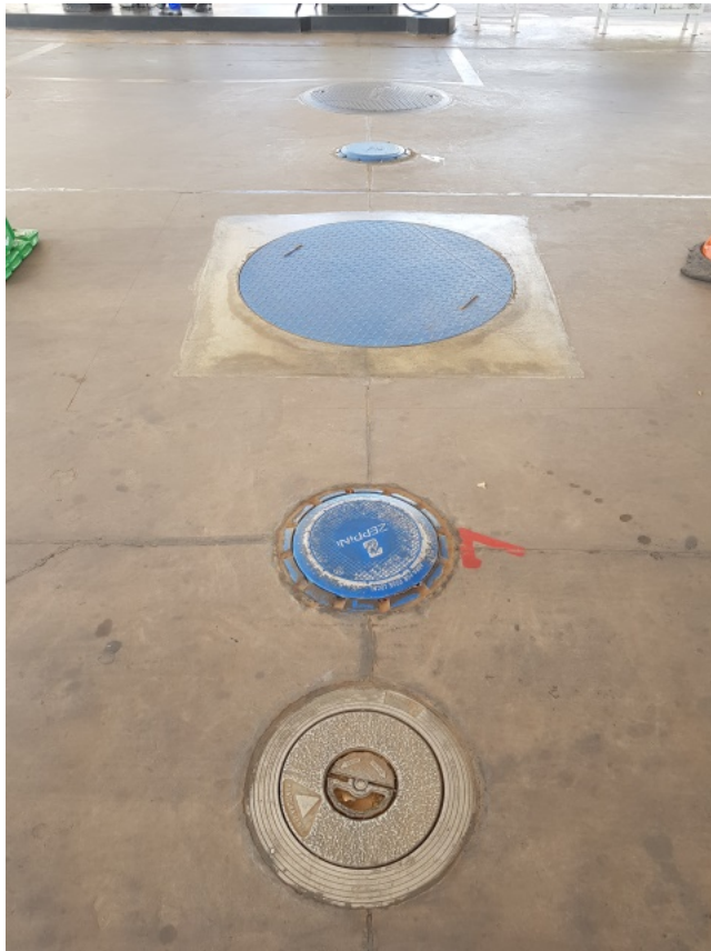
Foto 01 - Tanque bipartido localizado na área de abastecimento
