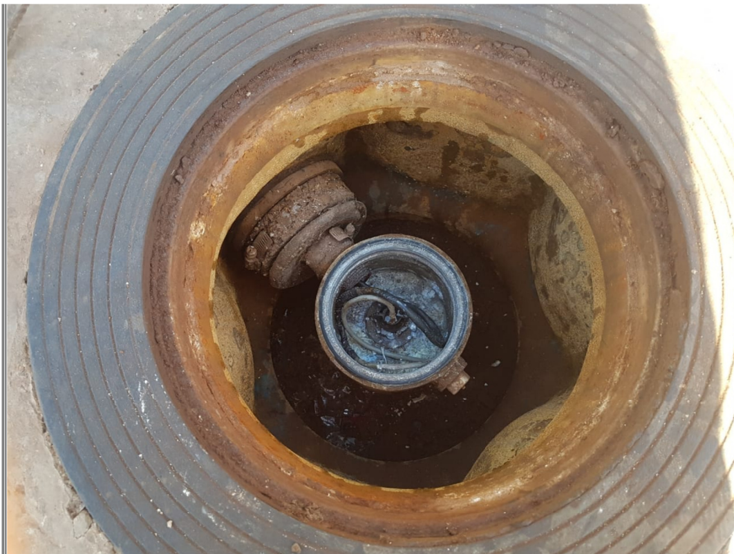
Foto 01. sistema de Monitoramento intersticial em péssimo estado de conservação o sensor não atingia o fundo do tanque
