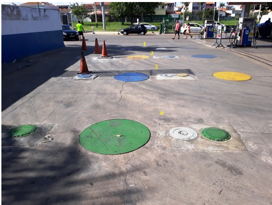
Figura 9 - Aspecto geral da área de tancagem do SASC dispondo de tanque do tipo pleno (1) e bipartido (2, 3 e 4) com capacidade que varia de 15 a 30 m 3 .
