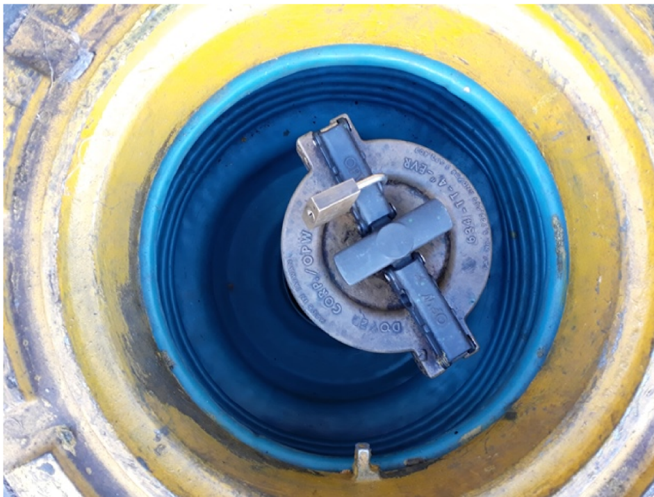
Figura 18 - Aspecto de um dos 7 (sete) dispositivos do conjunto da Descarga Selada à Distância com câmara de contenção ( spill container ). Observa-se que o dispositivo está em bom estado de conservação. O dispositivo necessita de manutenção operacional constante conforme exige a ABNT NBR 15594-3:2008 tabela 1.
