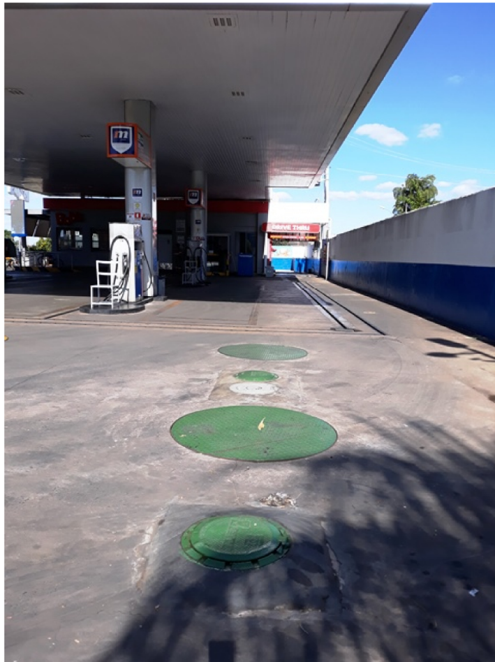
Figura 9 - Aspecto local da área de tancagem do SASC tanque bipartido (nº 4) com capacidade total de 30 m 3 .
