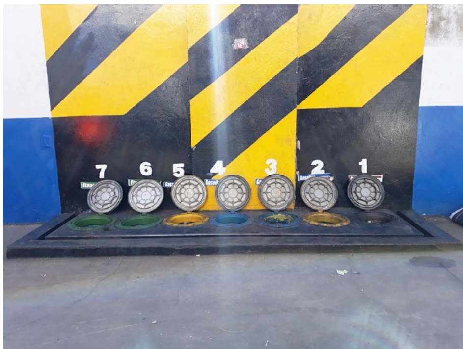
Figura 16 - Aspecto da Descarga selada à distância. Observa-se que o dispositivo é circundado por canaletas direcionadas ao SSAO da pista de abastecimento.
