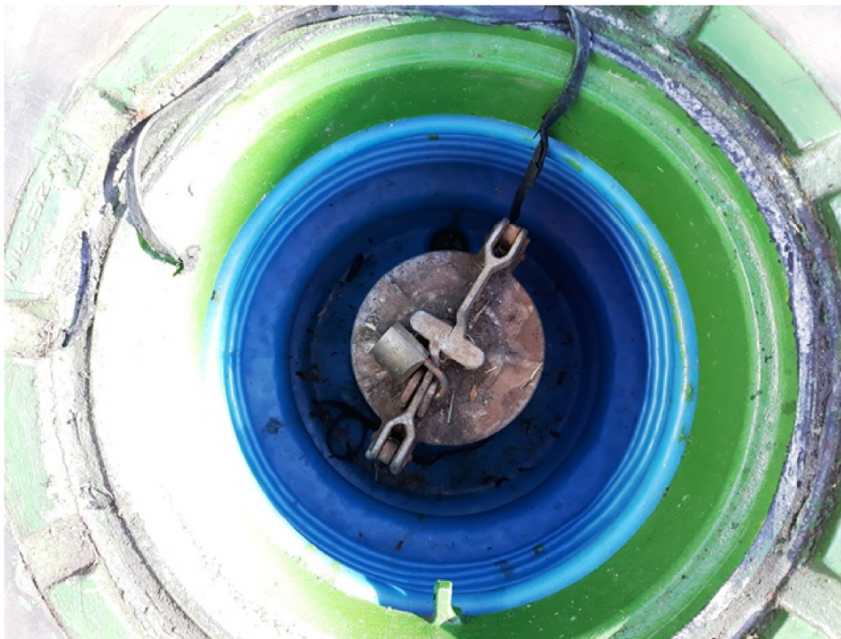
Figura 13 - Dispositivo de descarga selada sobre o tanque com câmara de contenção ( spill container ) e válvula anti-transbordamento. O dispositivo deverá ter manutenção operacional constante conforme exige a ABNT NBR 15594-3:2008 tabela 1.
