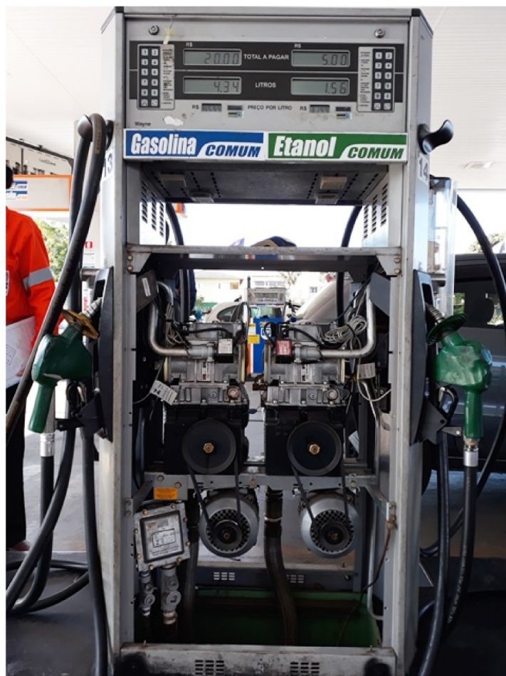
Figura 3 - Aspecto externo da Unidade abastecedora de Gasolina Comum e Etanol com o dispositivo de segurança check-valve , observa-se que a tubulação precisa de manutenção e está totalmente contida na câmara de contenção para unidade da bomba. A unidade necessita de manutenção operacional diária conforme exige a ABNT NBR 15594-3:2008 tabela 1.
