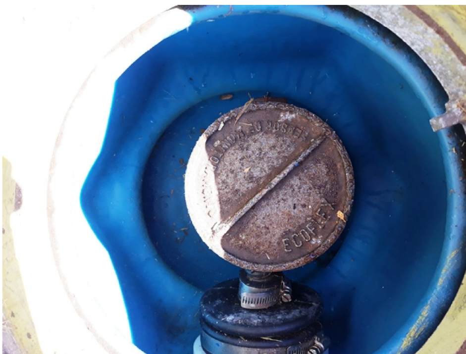
Figura 14 - Dispositivo do monitoramento do interstício do tanque de parede dupla. O dispositivo deverá ter manutenção operacional constante conforme exige a ABNT NBR 15594-3:2008 tabela 1.
