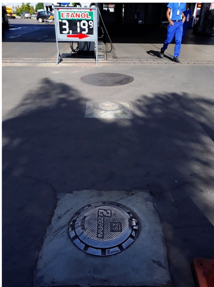
Figura 9 - Aspecto local da área de tancagem do SASC tanque bipartido (nº 1) com capacidade de 30 m 3 .
