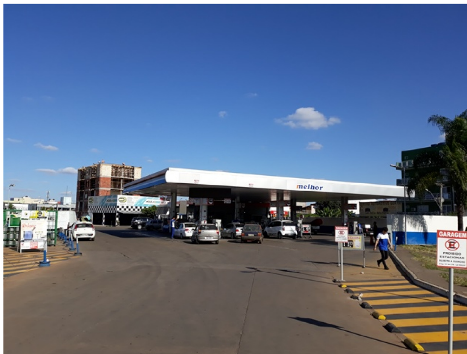
Figura 2 - Vista geral do posto.
