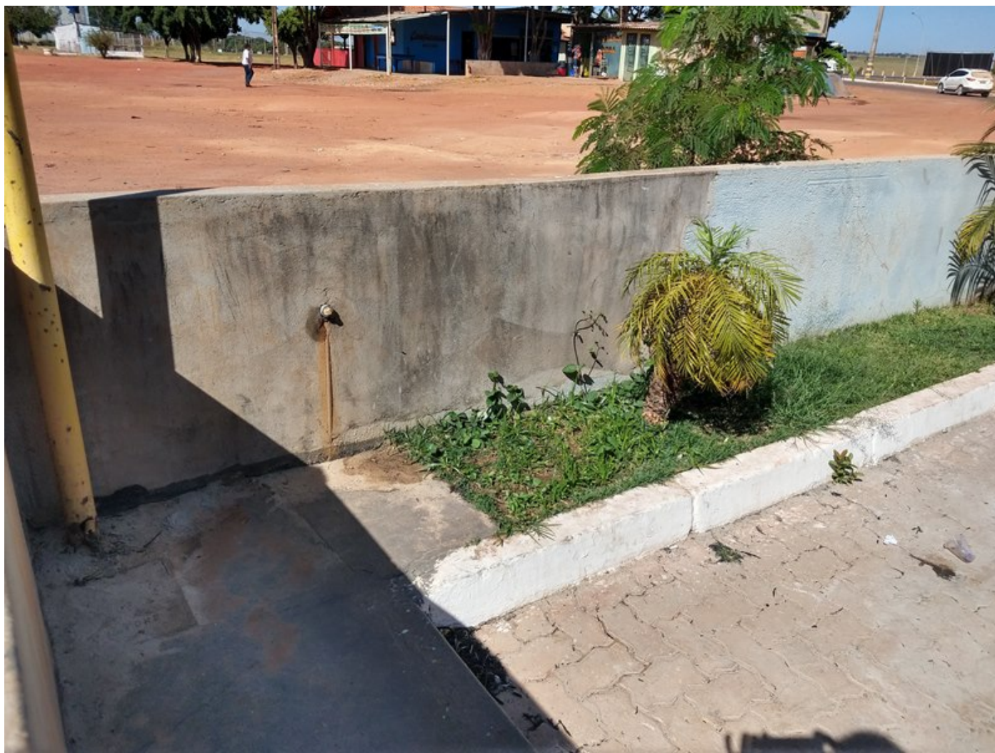
Figura 21 - Local da torneira que fornece água captada do poço, segundo funcionários não é possível manter a torneira instalada permanentemente por causa de furtos no local.
