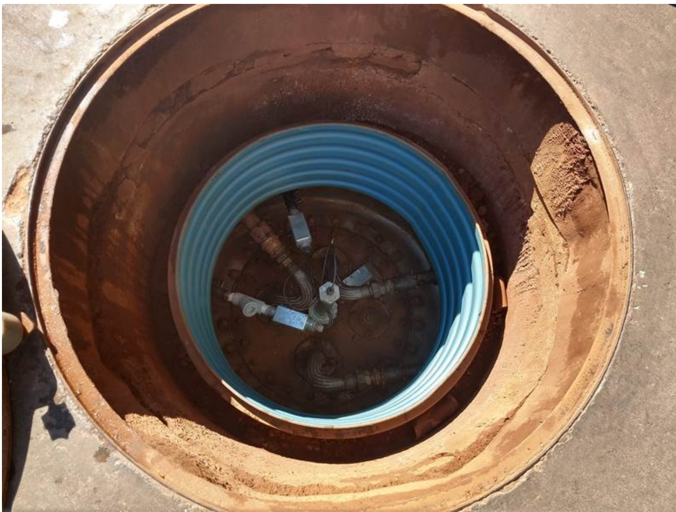
Figura 05 - Câmara de contenção do acesso à boca de vista do tanque.
