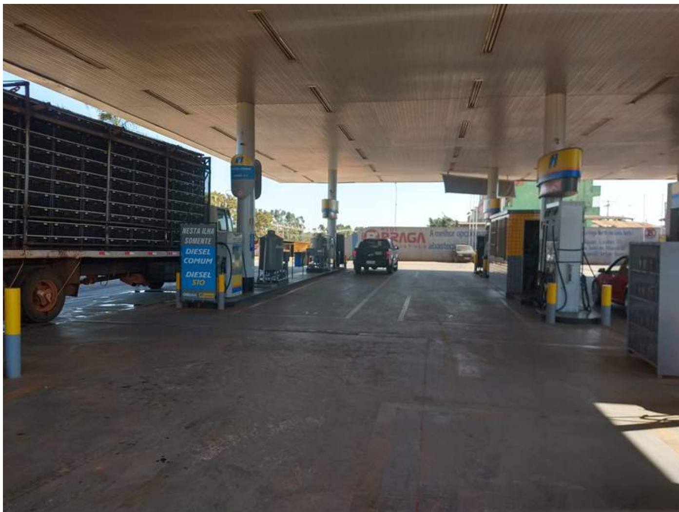
Figura 09 - Pista de abastecimento, coberta, cercada por canaletes direcionados ao sistema separador e piso impermeável.
