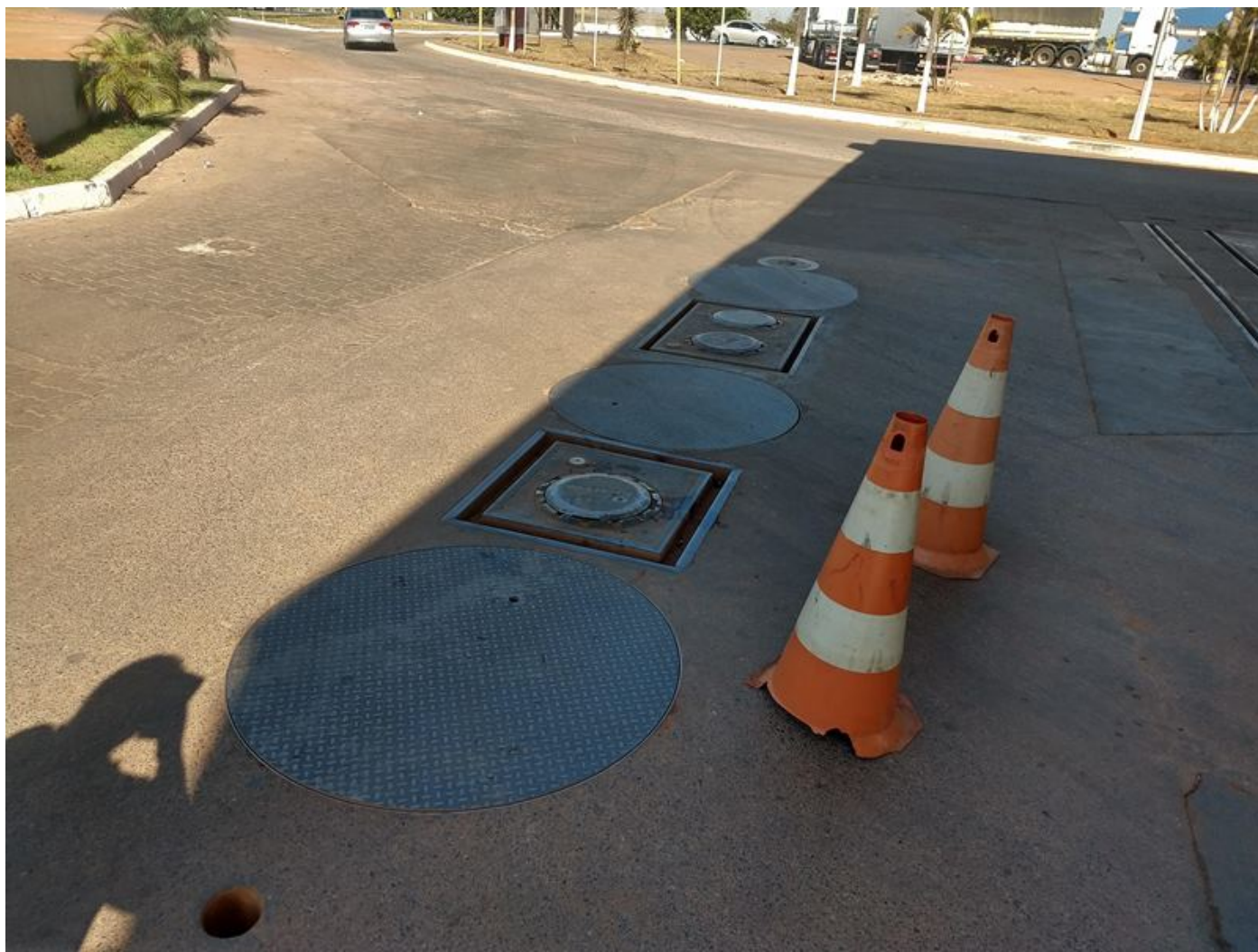
Figura 02 - Área do tanque tripartido, descargas seladas sobre o tanque cercadas por canaletas direcionadas ao sistema separador. O abastecimento é feito diretamente sobre as descargas seladas.
