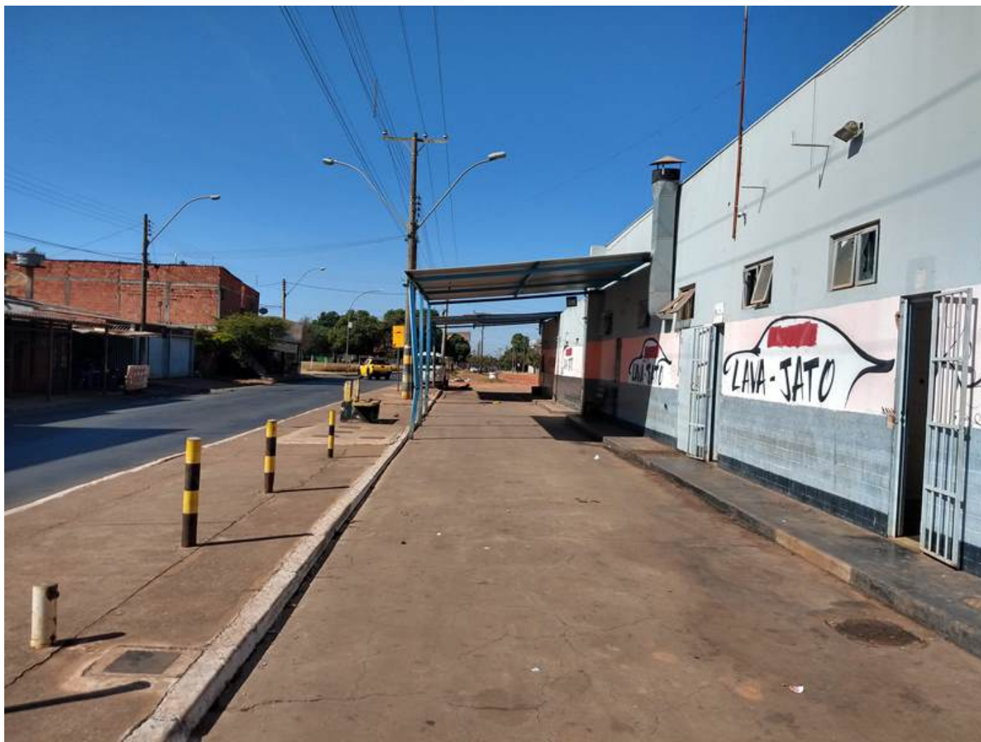
Figura 16 - Antiga área de lavagem de veículos (desativada) e antigos sistemas separadores.
