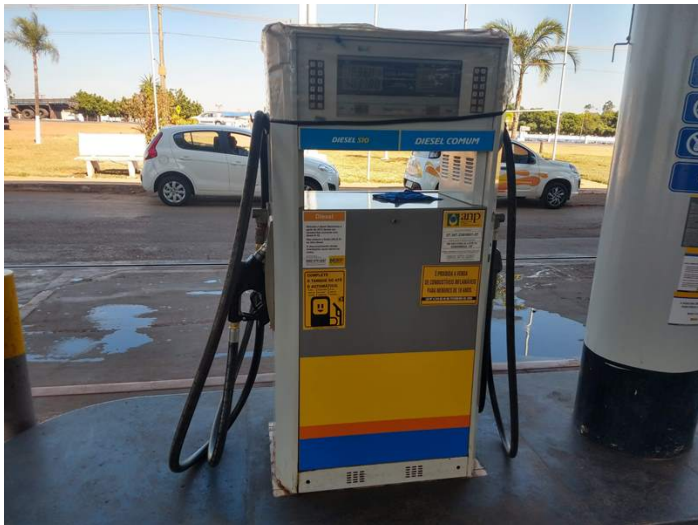
Figura 11 - Unidade abastecedora, modelo com dois bicos injetores.
