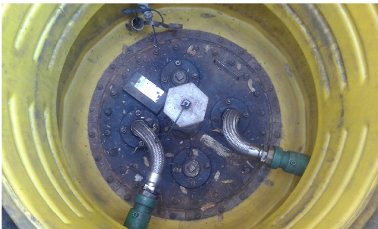
Figura 4: Boca de visita do tanque 1, com câmara de contenção, placa de identificação do ano de fabricação de 2006, sensor de monitoramento intersticial e com boa manutenção.
