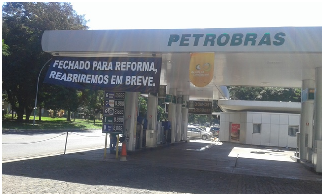
Figura 2: Vista Geral do Empreendimento. Nota-se que não se encontra em operação.
