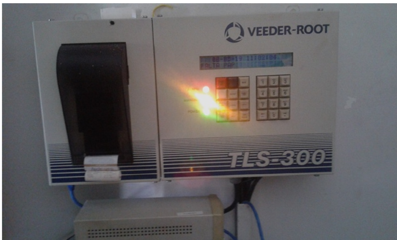
Figura 13: Aparelho de monitoramento ambiental e controle de estoque.
