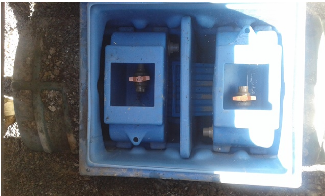
Figura 17: Caixa separadora de água e óleo do S.A.O. desativado da antiga área de lavagem.
