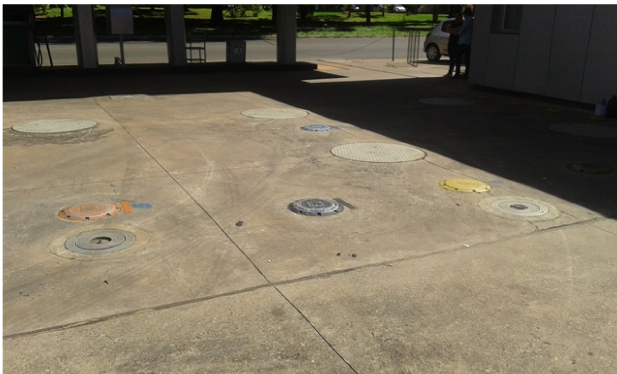
Figura 3: Área de tancagem que possui três tanques, um pleno e dois bipartidos de 30 m 3 cada.
