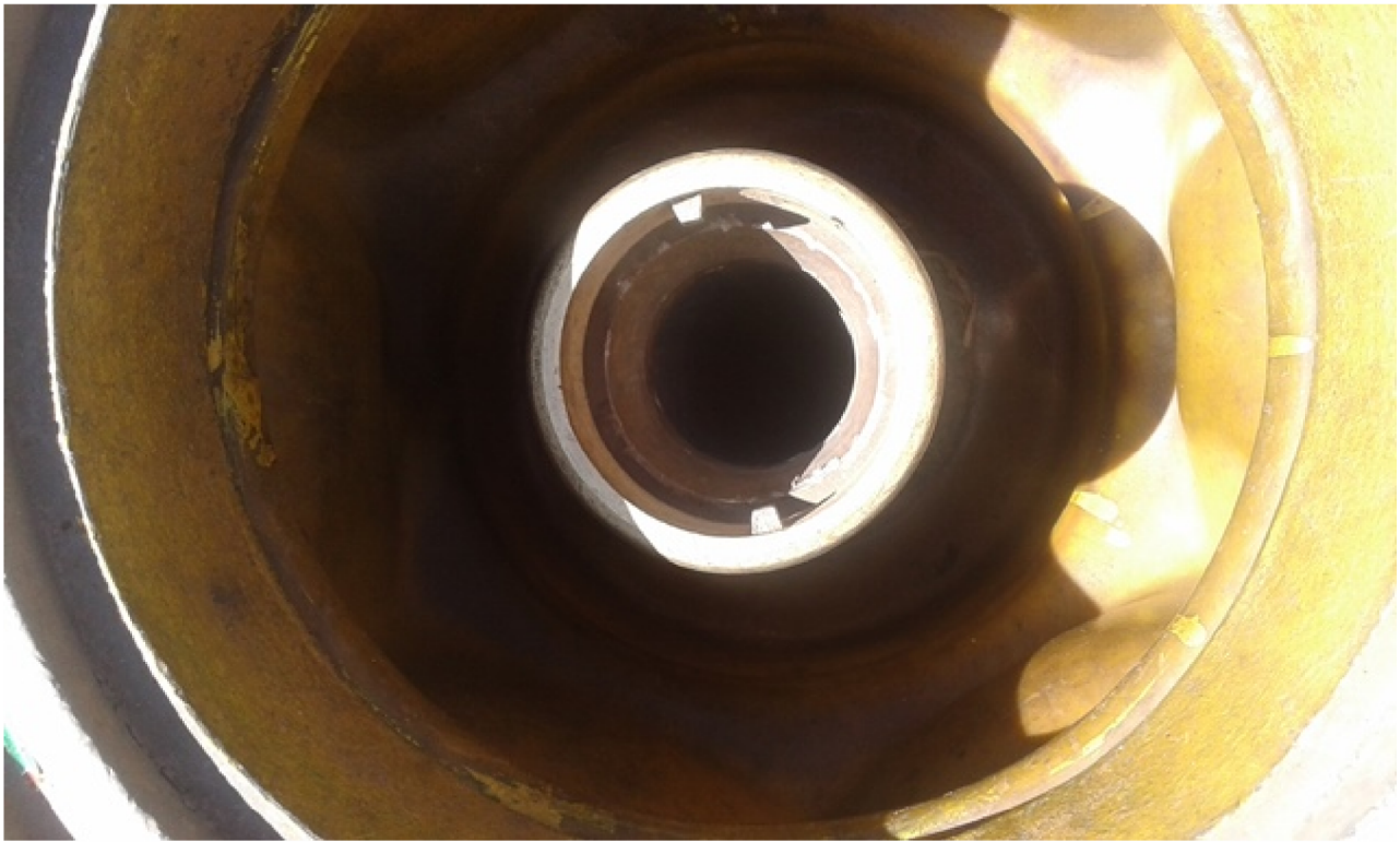
Figura 5: Descarga selada sobre o tanque com presença de válvula anti-transbordamento e com boa manutenção.
