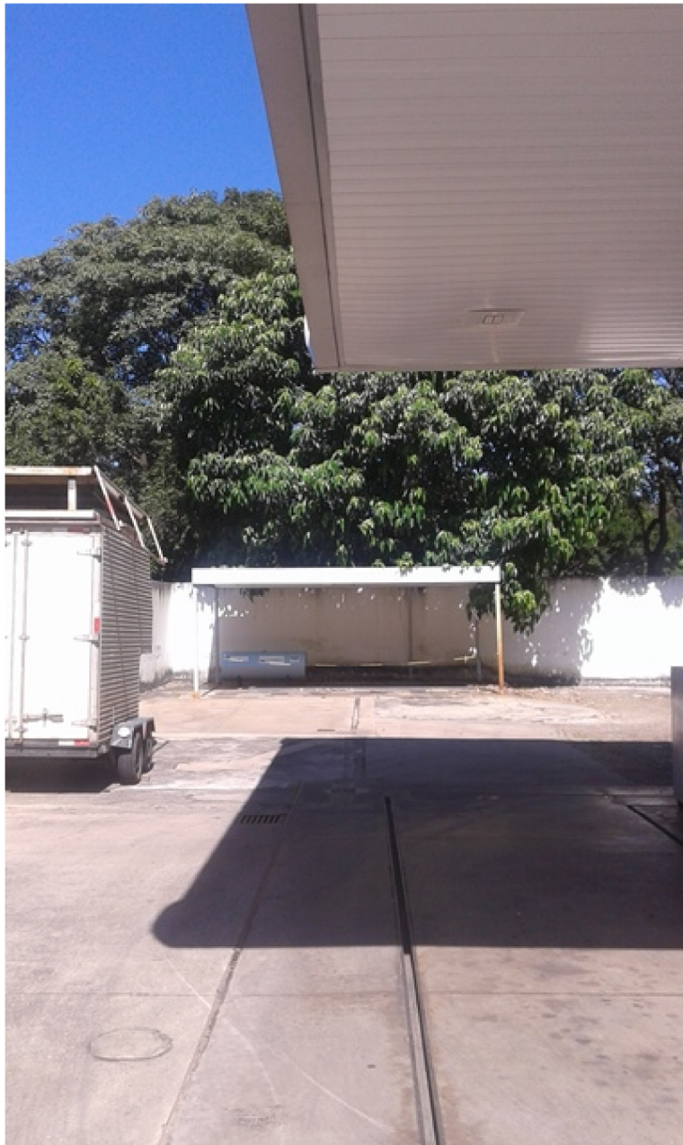
Figura 8: Canaleta da pista de abastecimento com a devida cobertura e segundo norma vigente.
