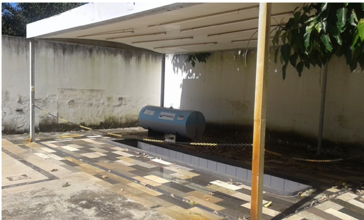
Figura 14: Área de lubrificação de veículos contemplada por canaletas com cobertura, uma vala para lubrificação e tanque de OLUC. Esta área encontra-se inativada.
