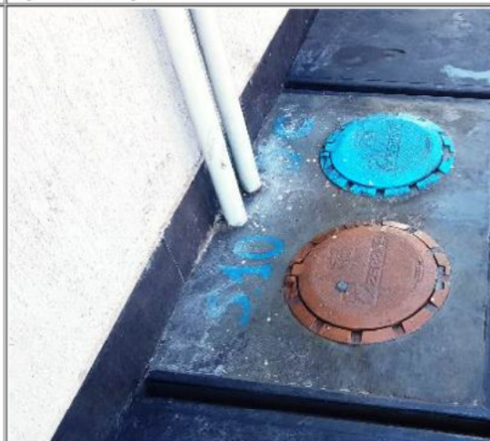
Foto 6 - ponto de abastecimento a distância de diesel comum e
