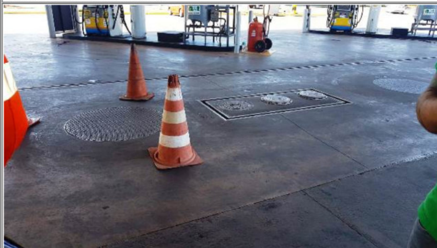
FOTO 5 - ponto de abastecimento sobre os tanques com canaletas e em uso gasolina comum, aditivada e etanol
