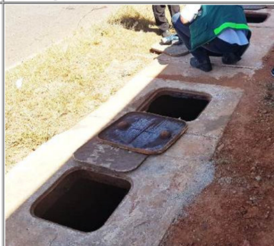
Foto 10 - SAAO com 4 etapas, originalmente com duas na vista
