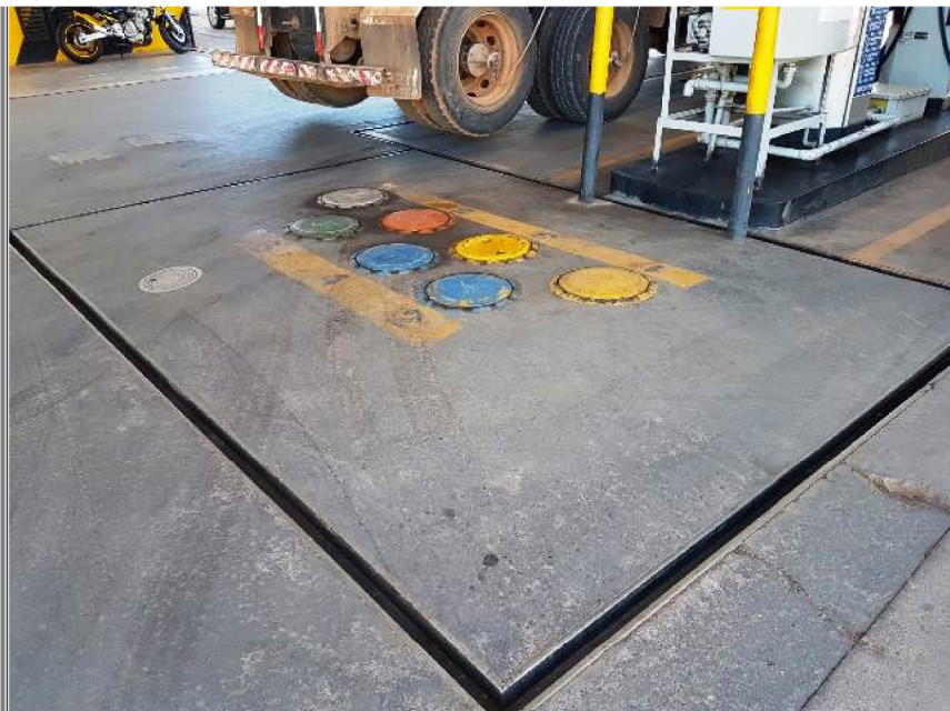
Foto 3 - Descarga selada cercada de canaletas sob a cobertura
