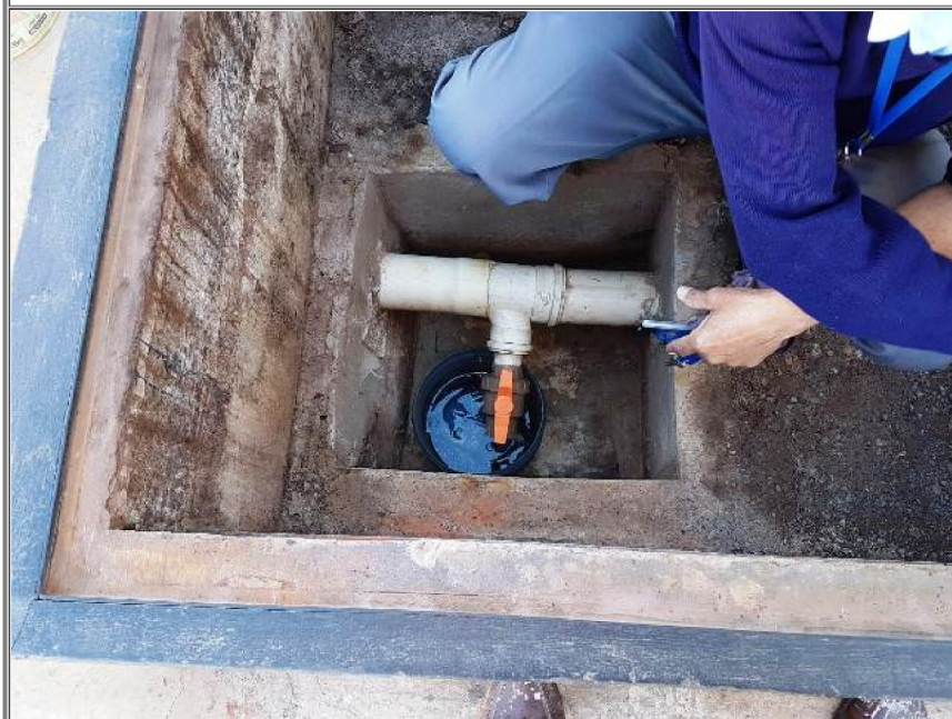
Foto 11 - Ponto de coleta do efluente oleoso do SAO
