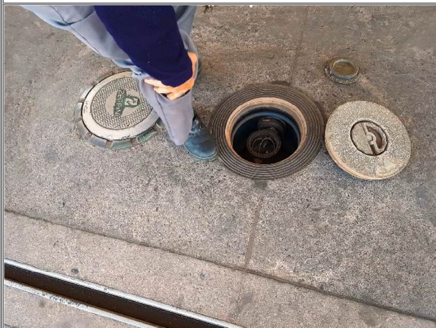
Foto 5 Monitoramento intersticial instalado e nivelado corretamente
