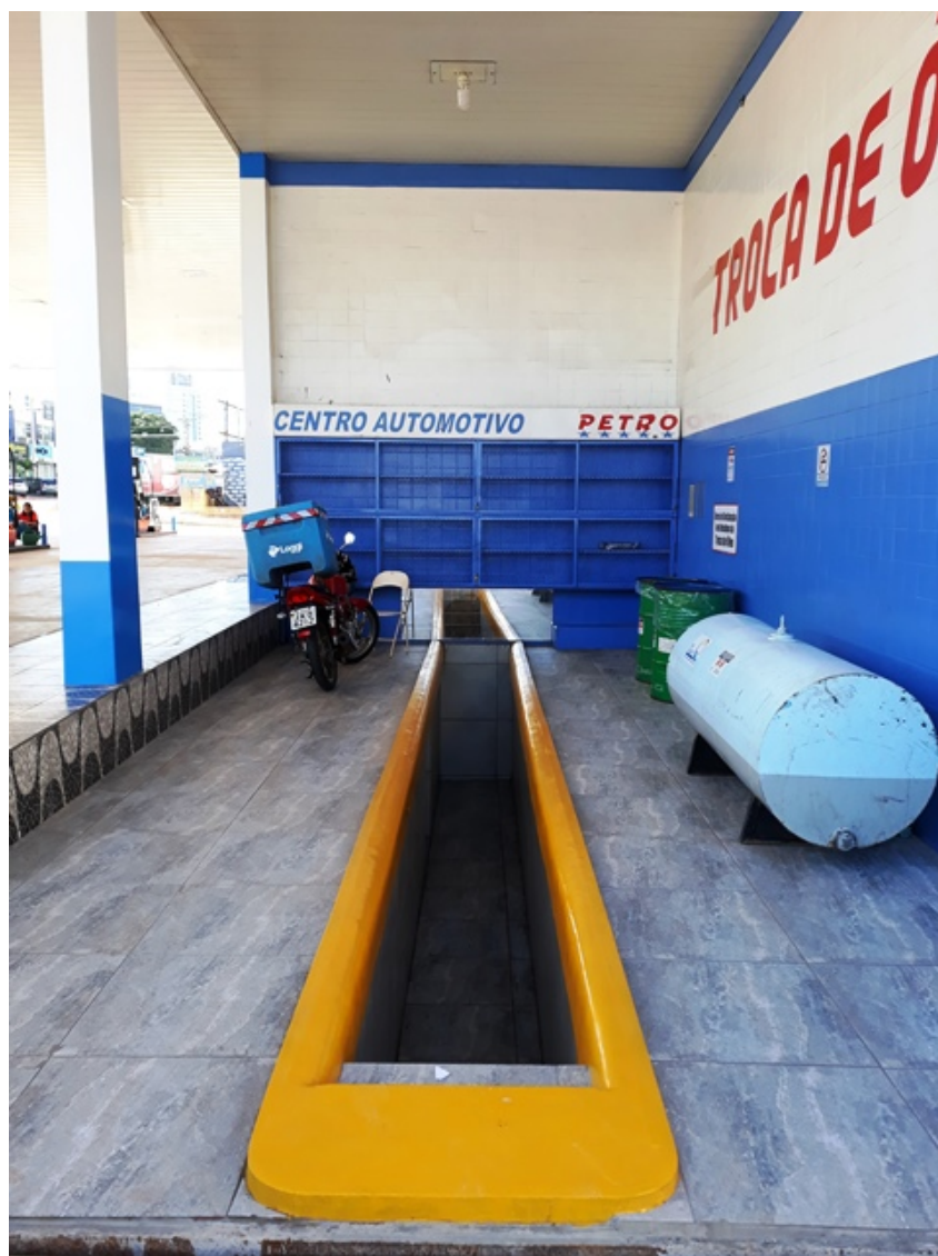
Figura 21 - Área de lubrificação de veículos com cobertura, canaletes, tanque OLUC e barril de armazenamento de embalagens de óleos usadas. Observa-se que o local é totalmente coberto e possui canaletes somente na parte frontal.
