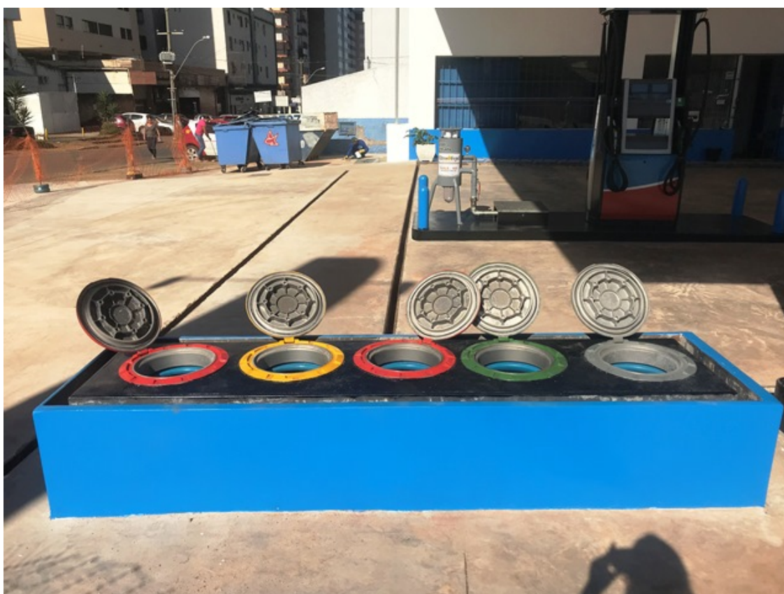
Figura 15 - Verificação no local do Monitoramento do interstício de um dos SASC.
