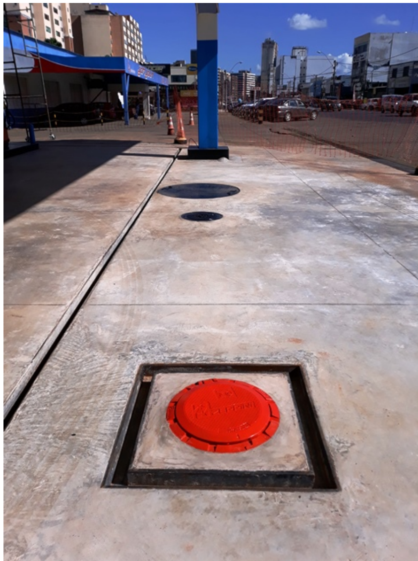
Figura 13 - Aspecto da área de tancagem do SASC tanque pleno com capacidade de 30 m 3 .
