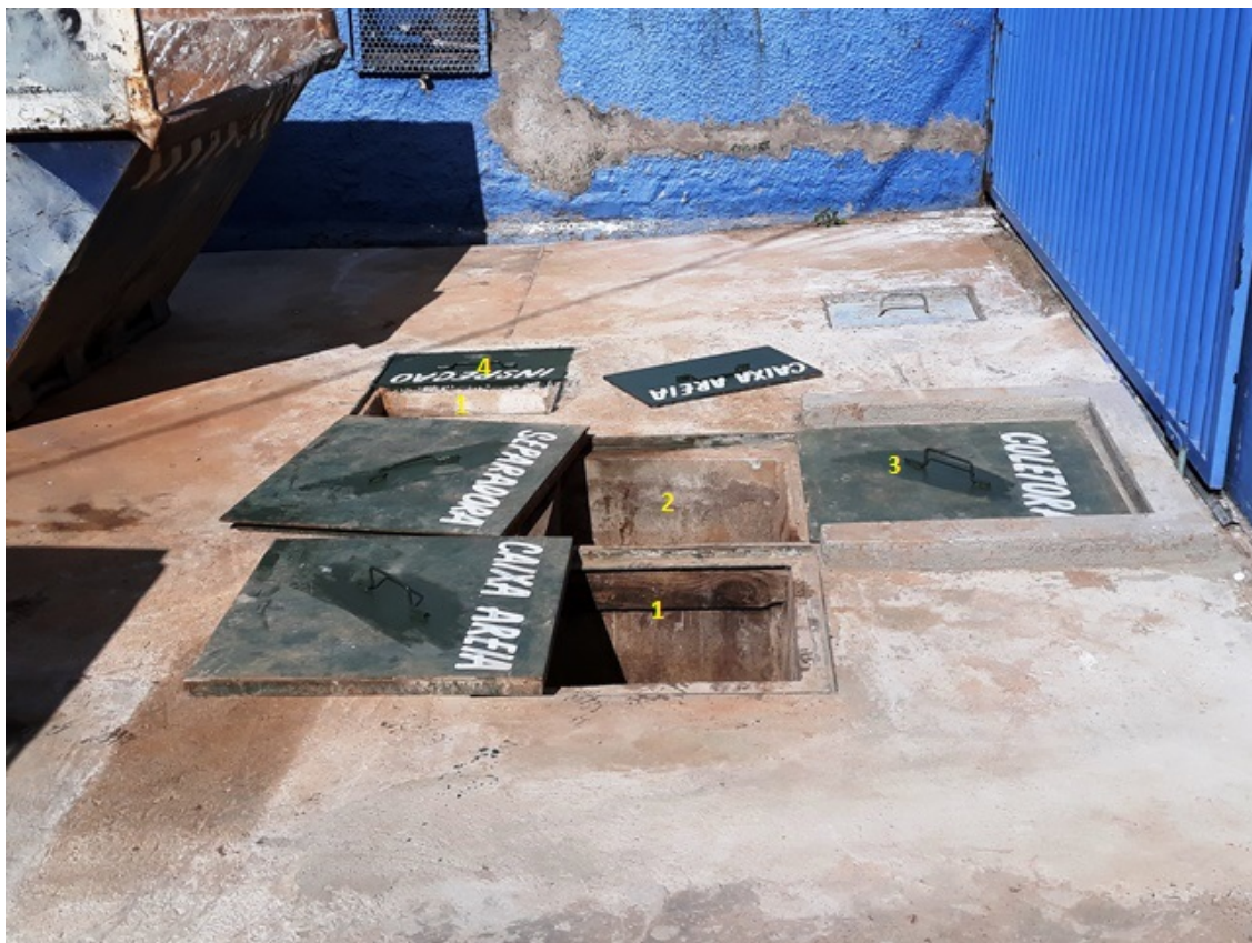
Figura 22 - Aspecto geral do Separador de Água e Óleo da área do lava Jato. O sistema possui Caixa de areia (nº1), Caixa separadora de água de óleo (nº2), caixa coletora de óleo e caixa de amostragem de efluentes (nº3) e caixa coletora de óleo (nº4). O sistema quando entrar em operação deverá realizar manutenção operacional semanal conforme exige a ABNT NBR 155943:2008 tabela 1.
