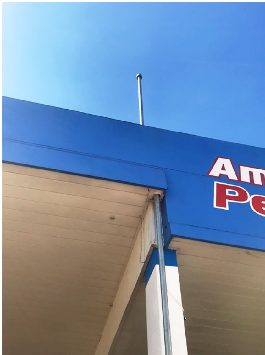
Figura 10 - Respiro com terminal corta chamas em conformidade com o que é exigido na ABNT NBR 13783:2014 item 8.3.4.
