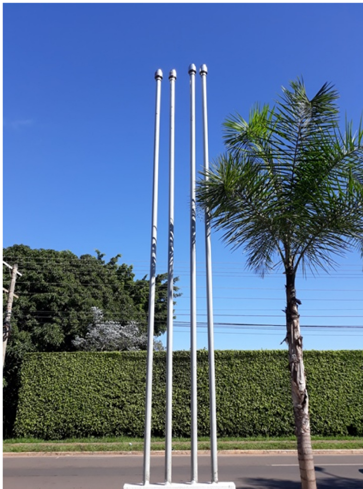
Figura 10: Conjunto B de respiros com terminal corta-chamas.
