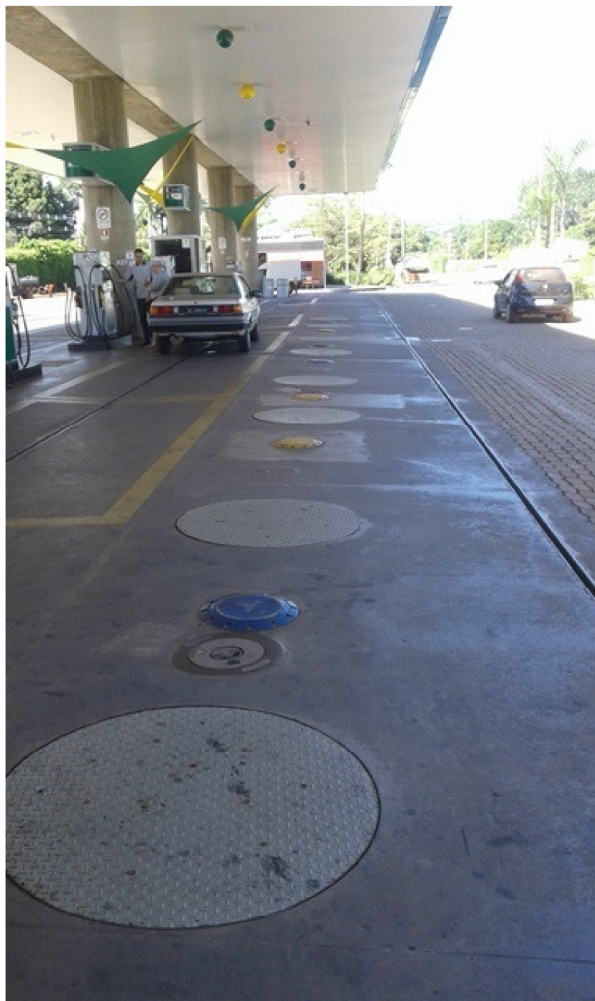
Figura 3: Aspecto da área de tancagem com com 4 tanques subterrâneos do tipo bicompartimentado de parede dupla.
