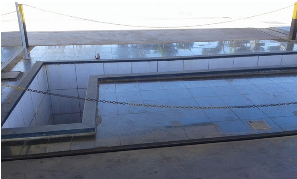
Figura 19: Área de lubrificação com 1 vala de lubrificação, dentro da pista de abastecimento, coberta, com piso em cerâmica e cercada por canaletes. Esta área está desativada.
