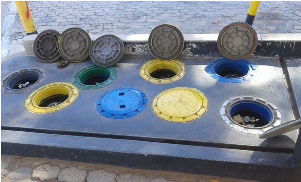
Figura 6: Aspecto frontal da Descarga selada à distância.
