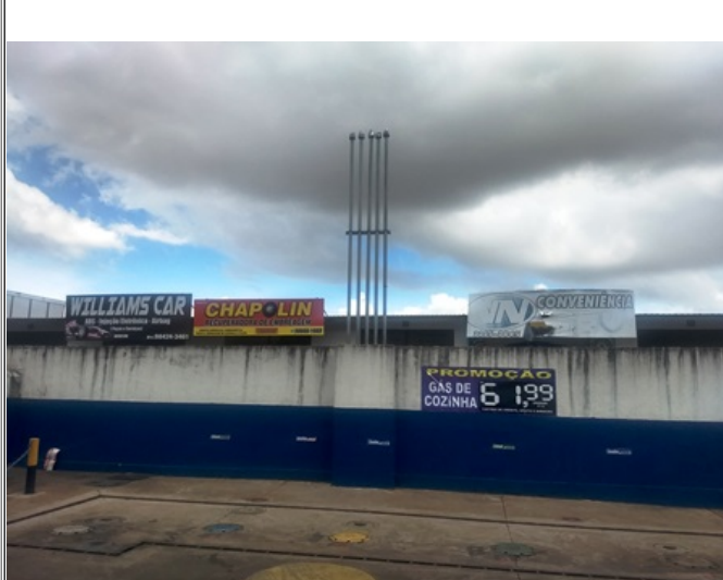
Foto 10 - Respiros com terminais corta-chamas.
