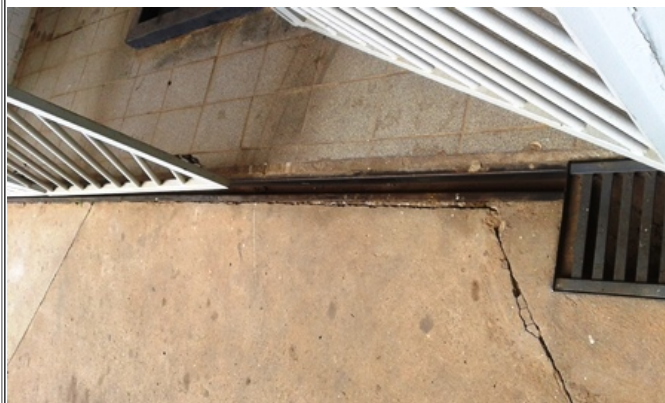
Foto 25 - Canaleta integrante do SDO localizado na entrada da área de lubrificação.
