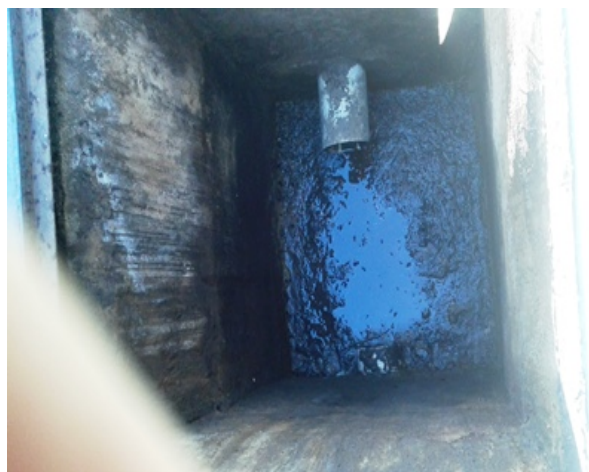
Foto 21 - Caixa de amostragem (SSAO área de lavagem).
