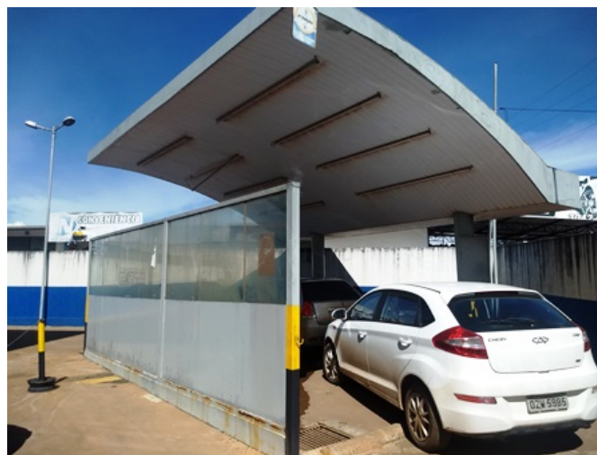
Foto 18 - Área de lavagem de veículos.
