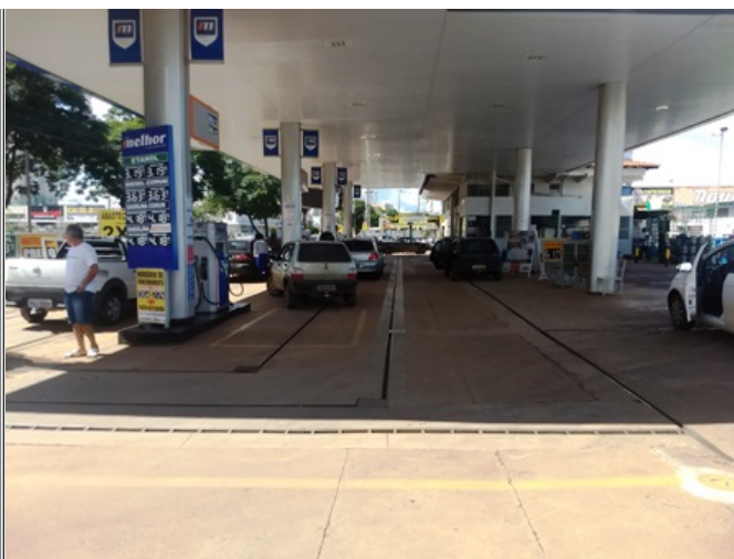
Foto 12 - Visão geral da pista de abastecimento.
