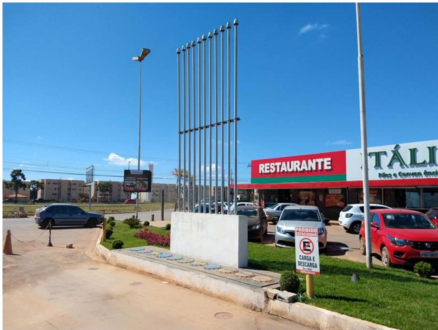
Figura 12 - Descargas seladas a distância, em local cercado por canaletas direcionadas ao sistema separador, observa-se também os respiros das câmaras de armazenamento dos tanques dotados de terminal corta-chamas.
