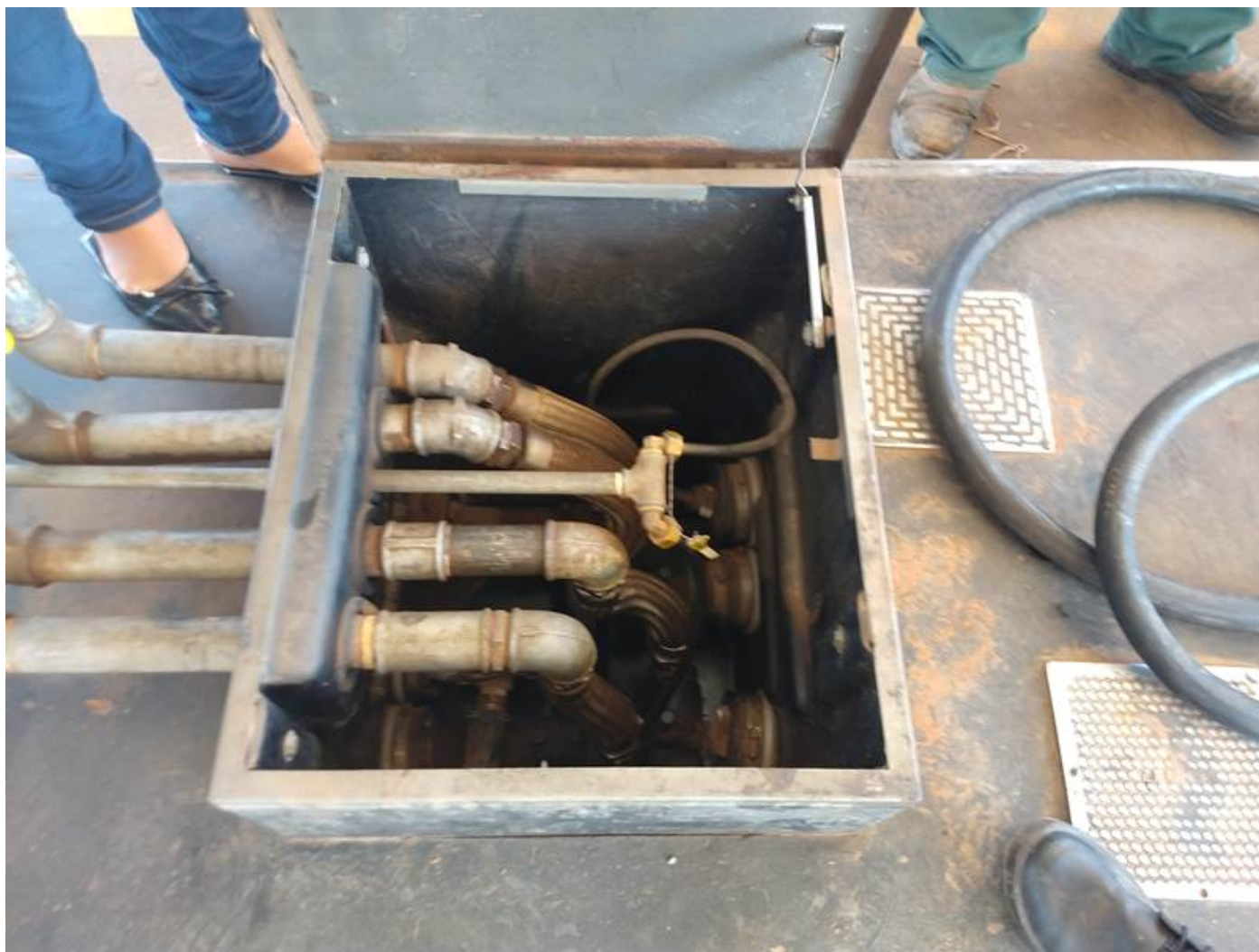
Figura 08 - Câmara de contenção da unidade de filtragem, observa-se boa na câmaras.
