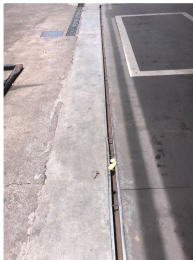
Foto 02: Canaletas em bom estado de manutenção.
