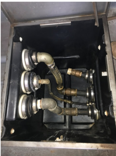
Foto 04 e 05: Sumps dos filtros de diesel em excelente estado de manutenção.
