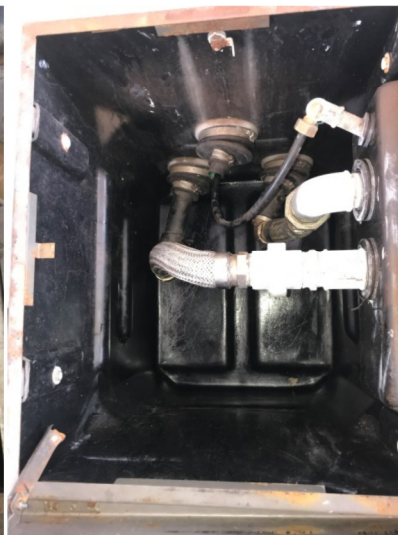
Foto 04 e 05: Sumps dos filtros de diesel em excelente estado de manutenção.
