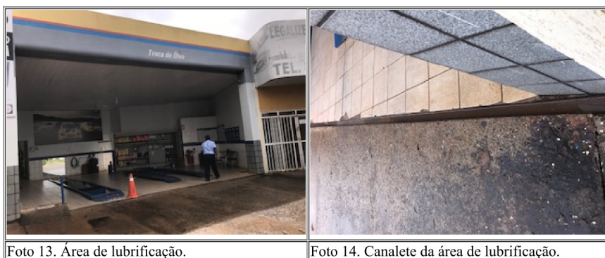
Foto 13. Área de lubrificação.
