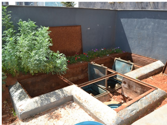
Foto 20 - Visão geral do SAO da área de lavagem.
