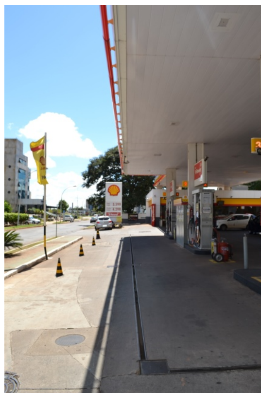
Foto 2. Canaletes com devido recuo de 0,5 metro.
