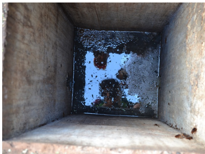
Foto 18 - Caixa de amostragem da área de abastecimento.
