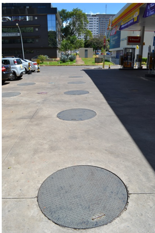
Foto 7 - Área de tancagem com os 5 tanques subterrâneos.
