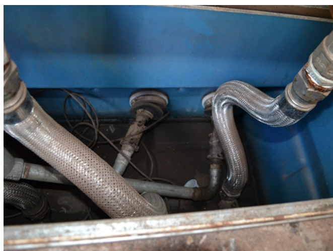
Figura 12 - Detalhe da câmara de contenção da unidade abastecedor.
