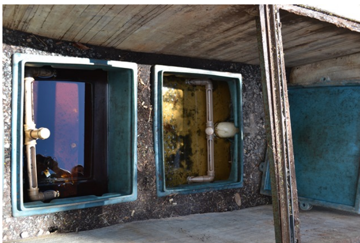
Foto 17 - Caixa separadora de água e óleo da pista de abastecimento.
