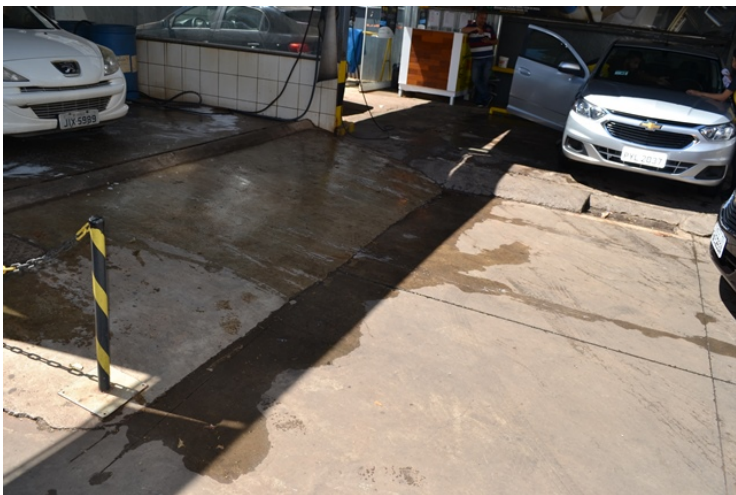
Foto 15 - Detalhe da área de lavagem com os efluentes escoando para área externa.
