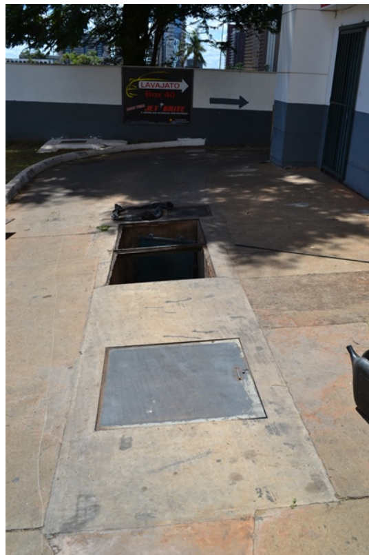
Foto 16 - Visão geral do SAO da pista de abastecimento.
