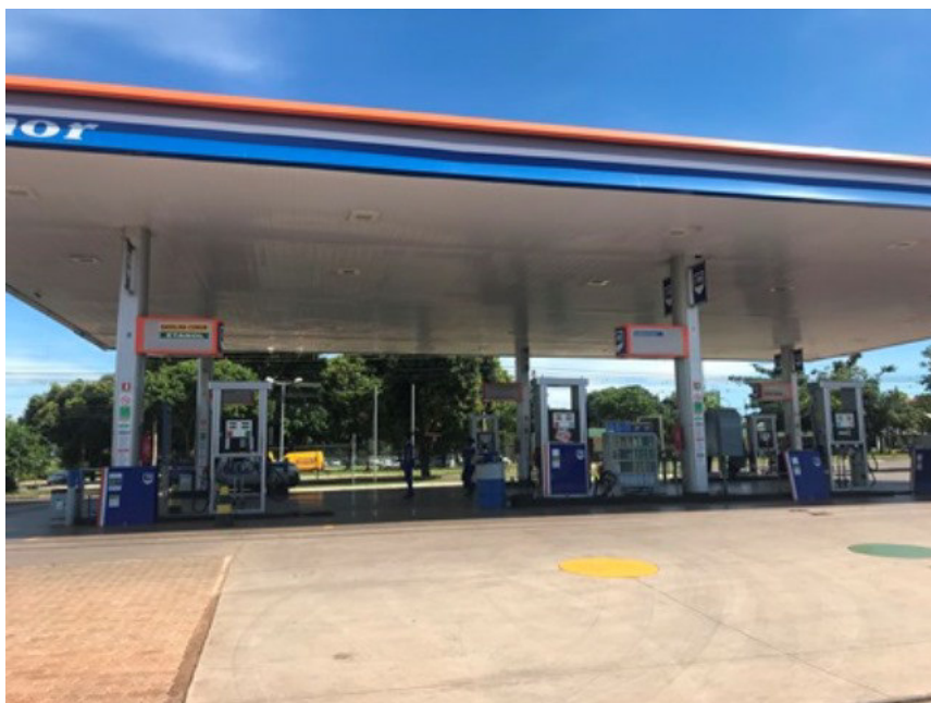
Foto 1. Visão geral do empreendimento.
