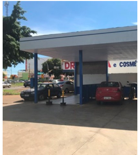
Foto 16. Visão geral da área de lavagem e lubrificação de veículos
