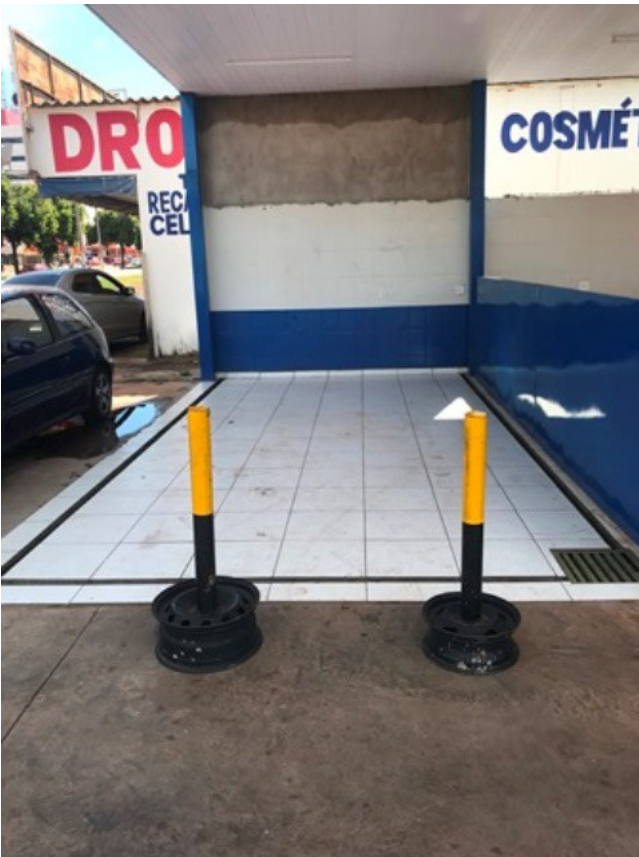
Foto 15. Área de lubrificação de veículos com barreira física.
