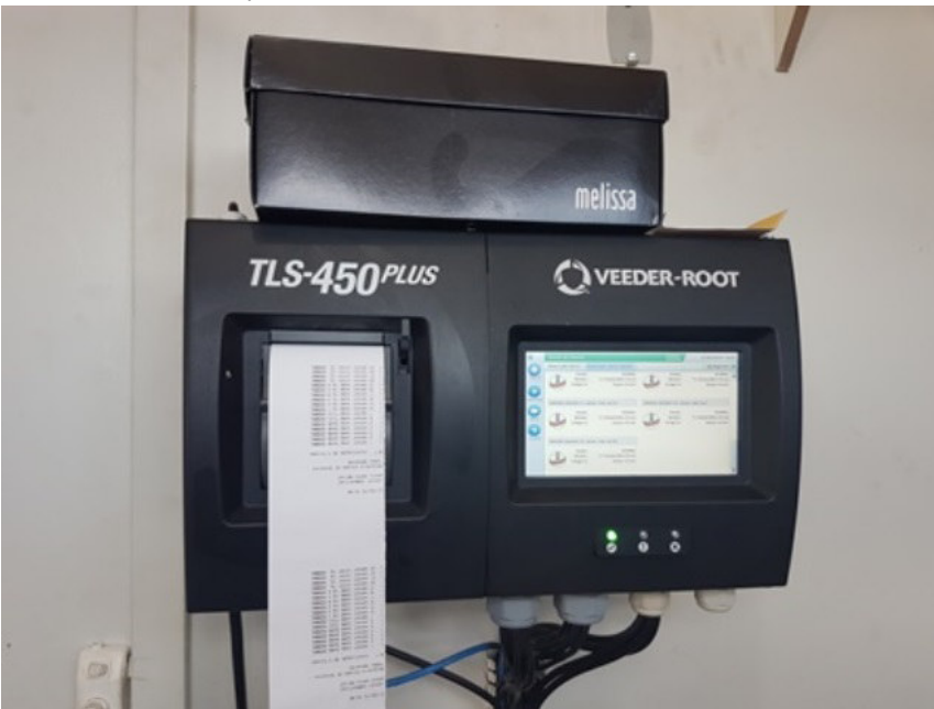
Foto 17. Sistema de monitoramento eletrônico Veeder - Root.
