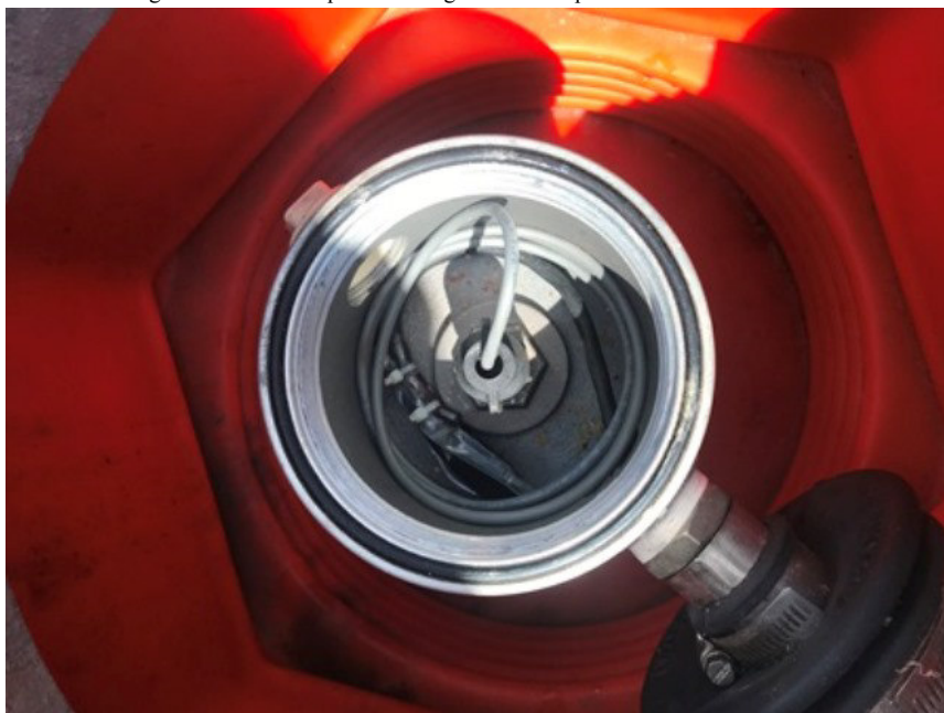
Foto 13. Detalhe do monitoramento intersticial.
