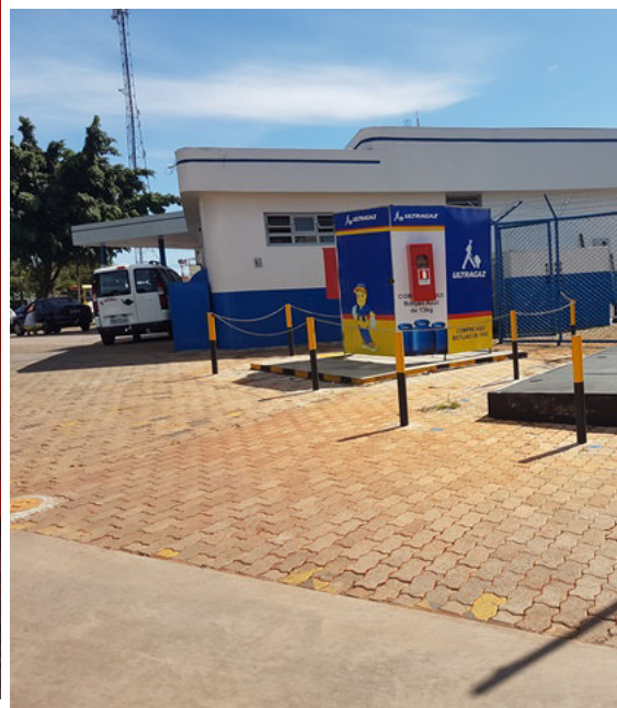
Foto 14. Visão geral da gaiola de armazenamento de GLP.
