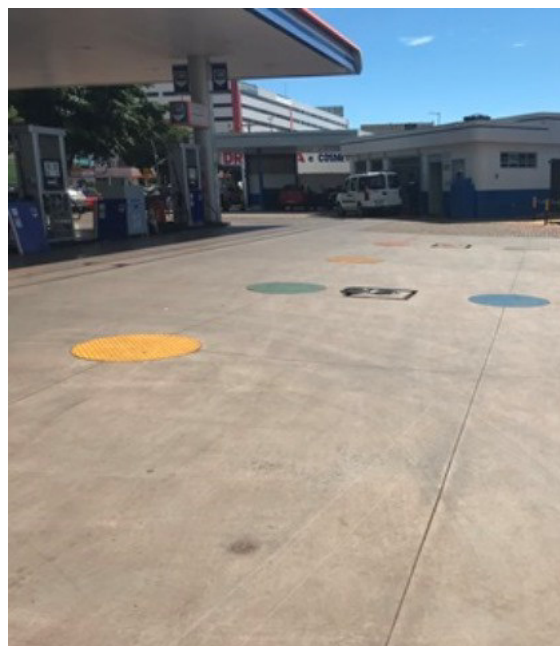
Foto 2. Visão geral da área de tancagem, com as descargas selada
