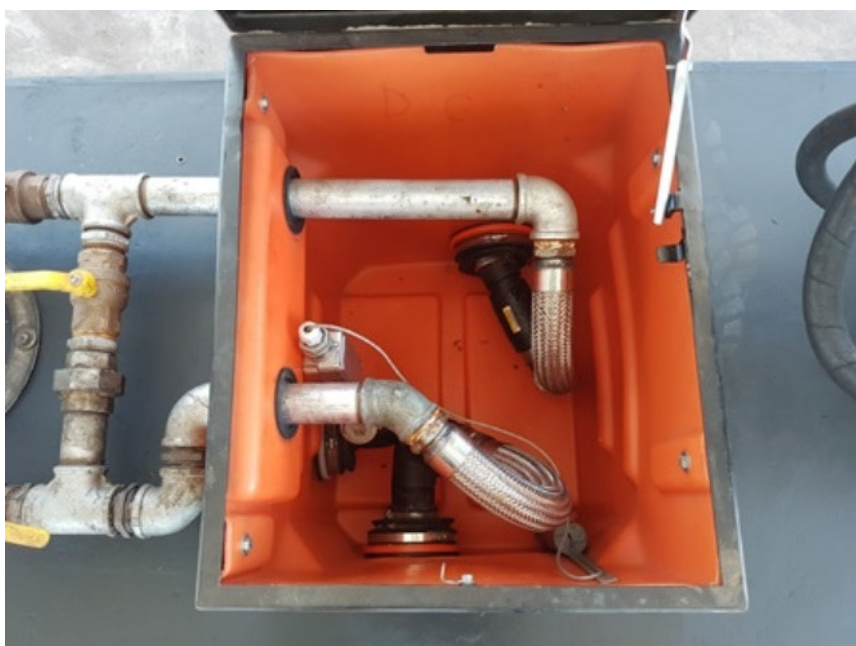
Foto 5. Detalhe da câmara de contenção do filtro de diesel.
