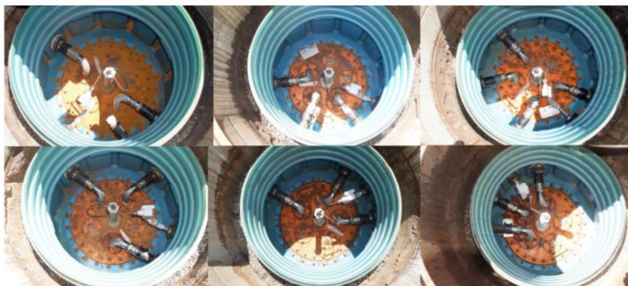
Figura 2: Tanques de combustível e dispositivos de segurança -Câmara de acesso à boca de visita
