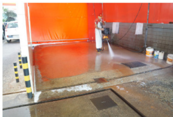
Figura 16 - Área de Lavagem - Canaletes circundando a área de lavagem e Piso impermeável
