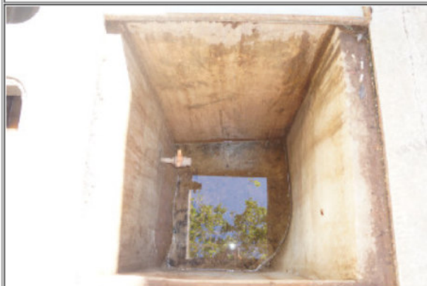
Figura 21 - Sistema separador de Água e Óleo da lavagem - Caixa coletora de óleo
