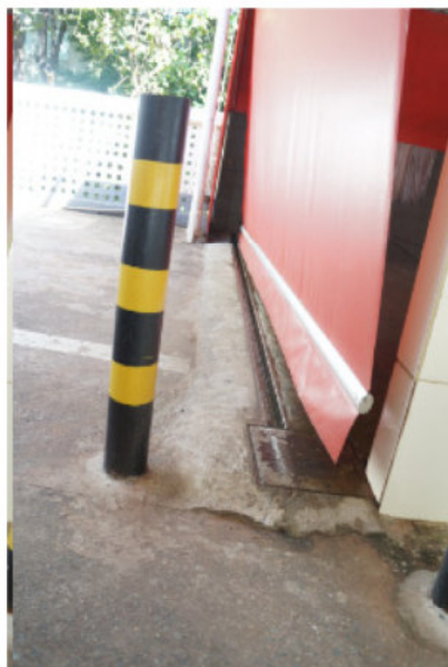
Figura 17 - Área de Lavagem - Canaletes direcionados para o SAO exclusivo
