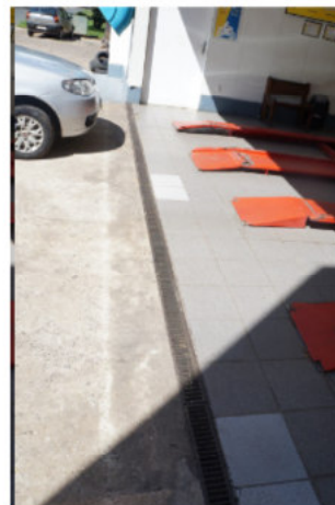
Figura 14: Área de Lubrificação e estocagem de óleo lubrificante usado - Canaletes circundando a área
