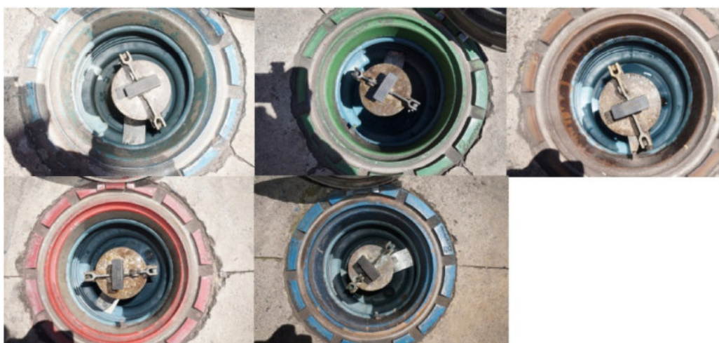
Figura 3: Tanques de combustível e dispositivos de segurança - Câmara de contenção nas descargas seladas sobre o tanque
