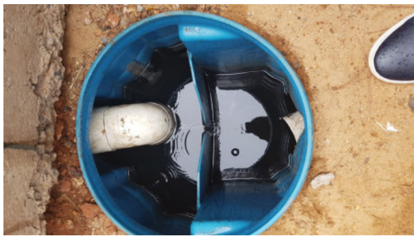
Figura 14: Módulo de inspeção do SAO da área de abastecimento
