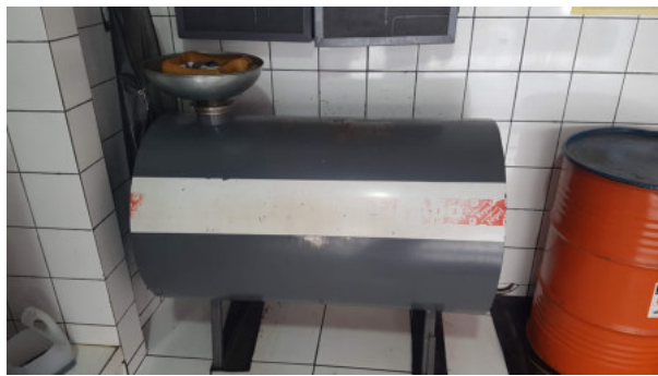
Figura 15 - reservatório de óleo lubrificante usado usado
