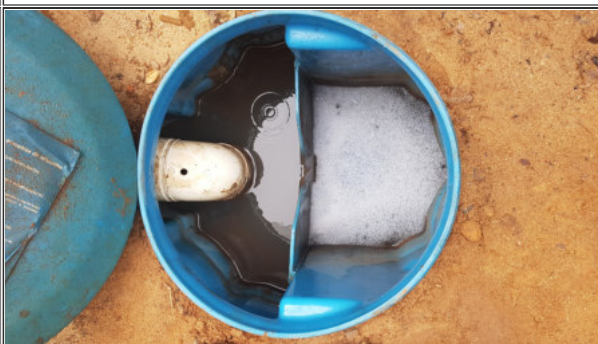
Figura 11: Caixas de areia da área de lavagem (esquerdo) e da pista de abastecimento (direito)
