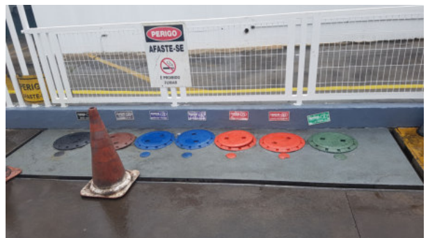
Figura 7: Área de descarga selada à distância e respiros
