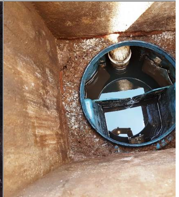
FOTO 12: ponto de saída do SAO para a rede de esgoto.
