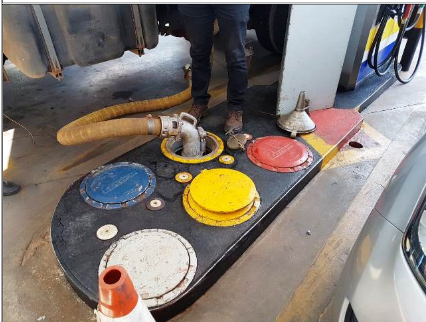
FOTO 3: descargas seladas, no momento do abastecimento. estavam limpos mas houve vazamento durante o abastecimento.
