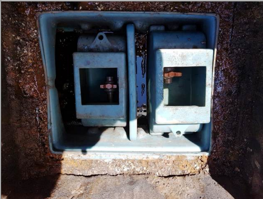
FOTO 11: SAO sistema secundário com separação do óleo esquerda e de coleta direita
