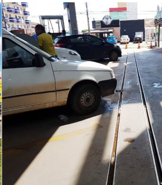
FOTO 2: canaletas da pista de abastecimento.
