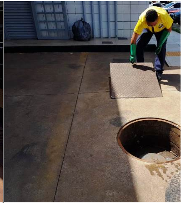
FOTO 18: Abertura do sistema SAA/SAO, ao fundo junto a parede respiro que possuem terminal corta chama.
