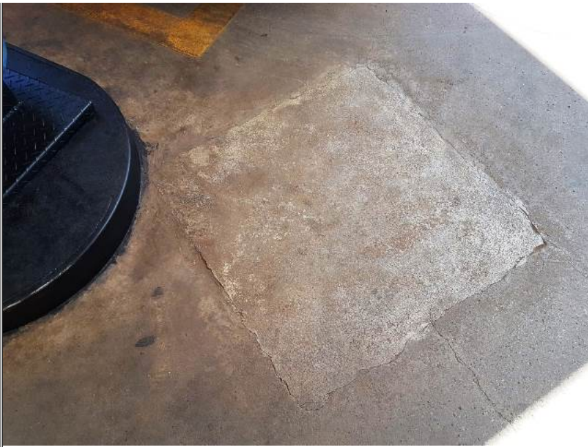
FOTO 13: área de escavação para ensaios na pista de abastecimento devidamente selado, e íntegro.
