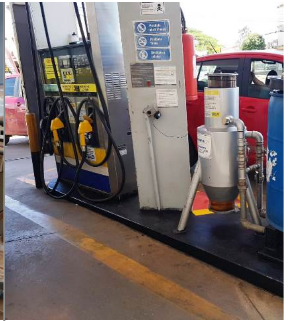
FOTO 6: Filtro de Diesel e o SUMP sob o barril de coleta de resíduo
