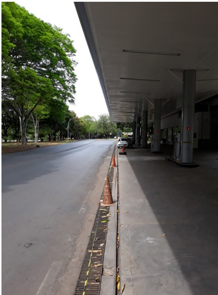
Figura 3: Canaletes da Pista de abastecimento com a devida cobertura, segundo a Norma vigente.
