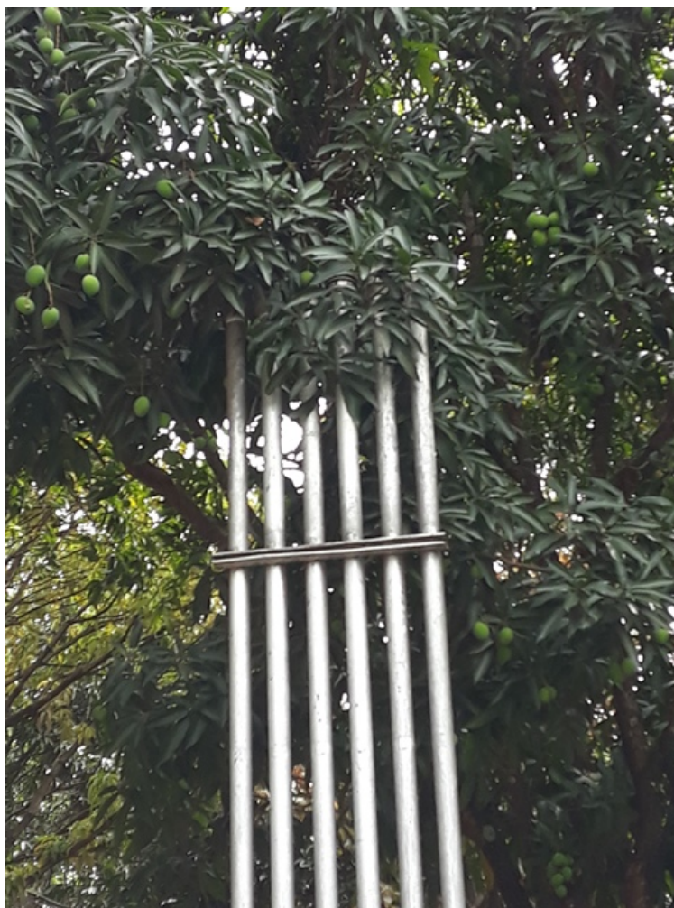
Figura 6: Conjunto de respiros com terminal corta-chamas.O documento 14671464 comprova a adequação de polda da árvore afim de liberar o terminal corta-chamas.
