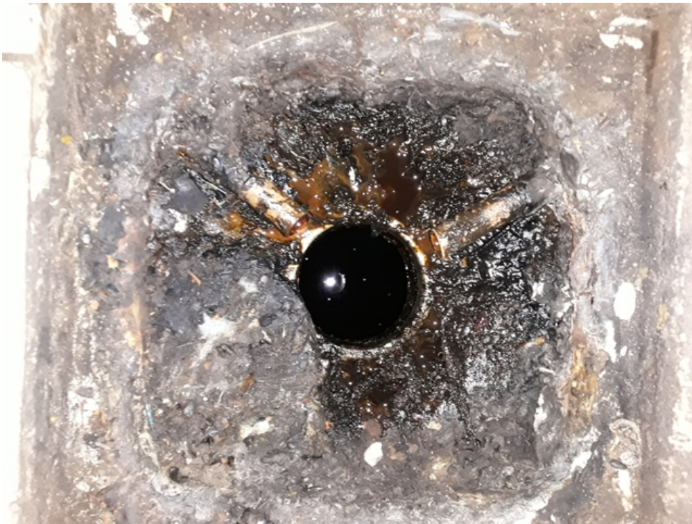
Figura 15: Tanque de OLUC subterrâneo de parede simples. Foi comprovada a inativação deste tanque e substituição por tanque aéreo (14671464).
