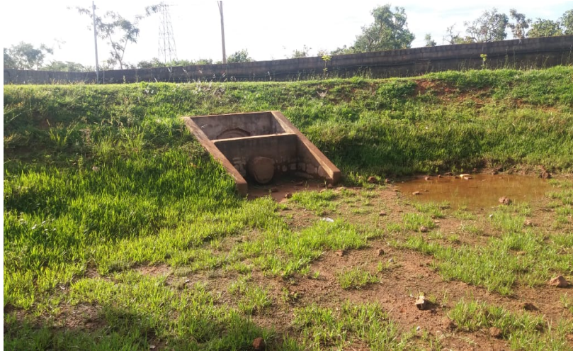
Figura 2- Descarga de fundo da bacia
