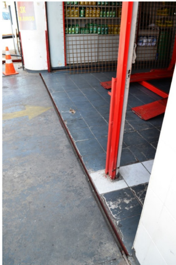
Figura 17 - Aspecto dos canaletes da parte frontal da área de lubrificação e manutenção de veículos.
