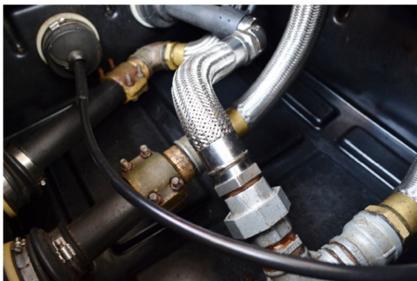
Figura 7 - Aspecto interno da câmara de contenção ( Sump ) da Unidade do filtro de Diesel. Observa-se que o sump está em bom estado de conservação.
