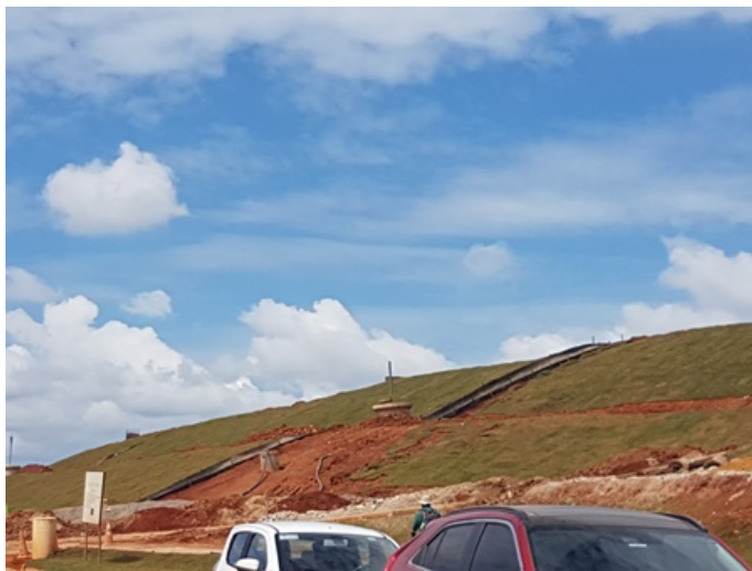
FOTO 1: Obras em execução na drenagem da berma.
