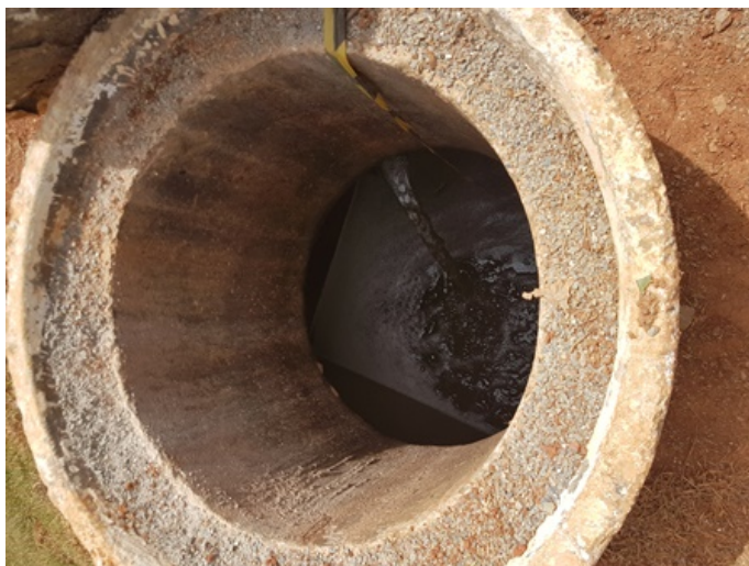
Foto 3 : Acúmulo de chorume no dreno vertical.
