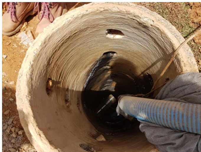
Foto 4: Mangote para bombeamento do chorume nos drenos verticais.
