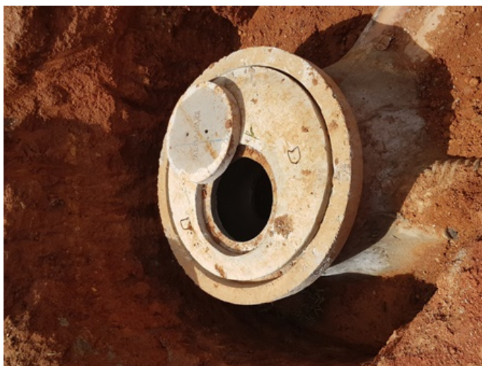
Foto 3 : Acúmulo de chorume no dreno vertical.
