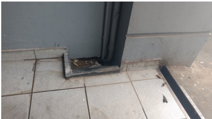
Figura 06 - Adequação da cavidade da área de lubrificação de veículos.
