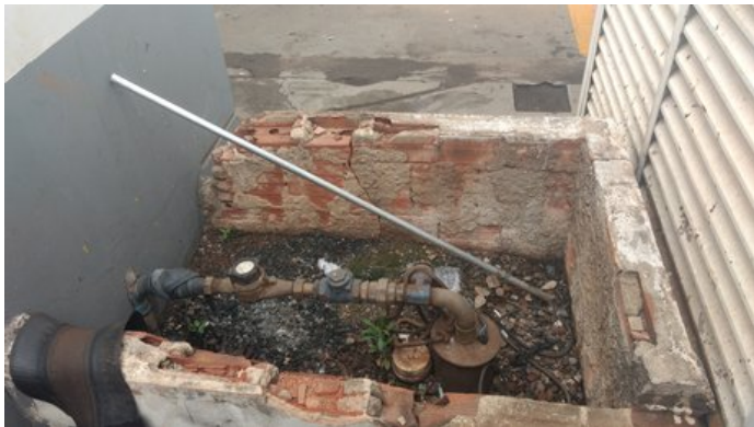
Figura 04 - Área do Ponto de Captação de Água, livre de materiais.
