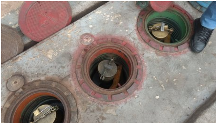
Figura 08 - Câmaras de contenção das descargas seladas a distância.
